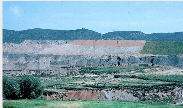
Figura 1.b. Imagen que muestra de izquierda a derecha las tres fases de la restauración. Perfilado topográfico, extensión del substrato y revegetación.
