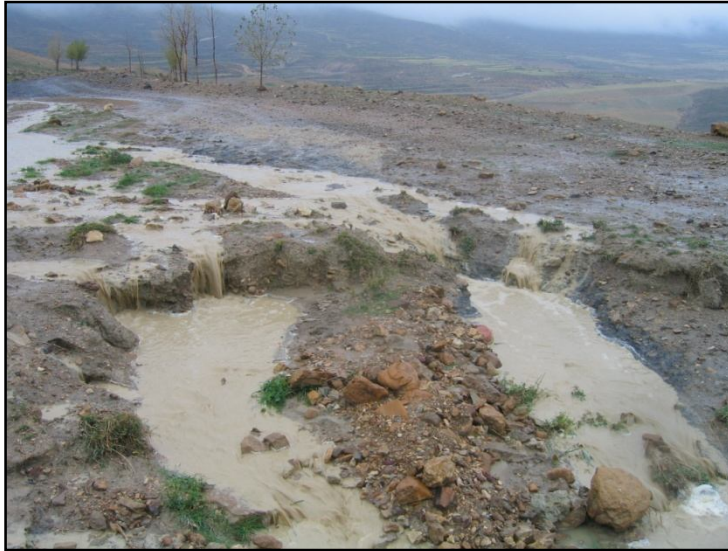
Fig. 1. Acumulación de escorrentía procedente de laderas restauradas y cunetas en las plataformas del Cerro del Moral.
