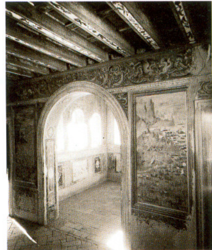
Arco de acceso al interior de la linterna, antes de la restauración. En primer término pintura de la conquista de Túnez. Instituto Amatller
