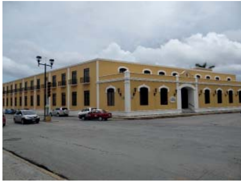
Fig. 14. Réplica de la fachada, reconstrucción y adecuación de la Estación de Tranvías Donde reutilizada como hotel en la primera década del siglo XXI. Fotografía: Carlos Domínguez Vargas, 2013.
