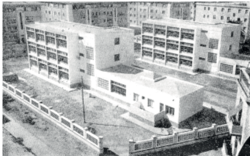
Fig. 1: Imagen de época del Grupo Escolar Vicente Ballester Fandós en los Poblados Marítimos. Valencia, 1958-1961. Fuente: Boletín de Información Municipal nº75, pág. 51 (1975).
