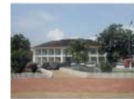
14. Reparação Central dos Serviços de Fazenda e Conceição, actual Finanças, Mário de Oliveira, GUU, 1951
