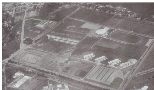
Fig. 4. Vista del Conjunto. 1969. Tomado de Caballero, 2003:66
