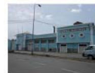
3. Central Eléctrica, CV OP, 1951
