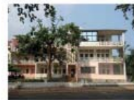
25. Edifício de 24 apartamentos para a Casa de Previdência, Mário de Oliveira, c.1984-1988
