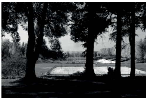
Fig. 8. Estado actual de los Campos de Deportes de la Ciudad Universitaria de Madrid tras su reconstrucción tras la Guerra Civil, construidos originalmente en 1931.
