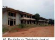
15. Pavilhão de Tisologia (actual Hospital 3 de Agosto, em ruínas), Lucínio Cruz, Mário de Oliveira, GUU, 1953
