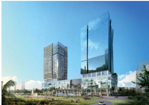
Fig. 21. Kinaxixe MXD Complex, Luanda. Proyecto en construcción ubicado en el solar del antiguo mercado.
