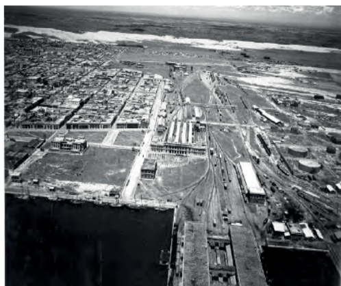
Fig. 5. Fotografía aérea con la estación del ferrocarril y el edificio de correos en la zona sureste del puerto de Veracruz (1929) perteneciente al Archivo Carlos Contreras. Tomada de Escudero (2009:116).
