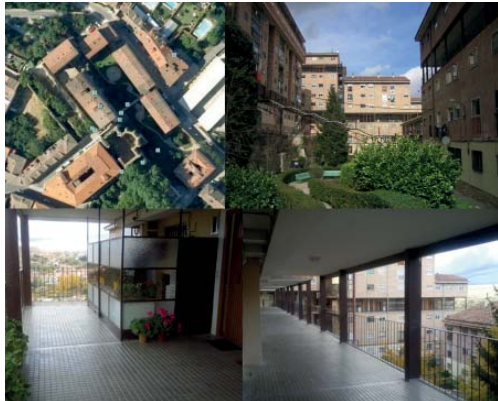
Fig. 2. Viviendas sociales Taray (Segovia) / Foto del autor
