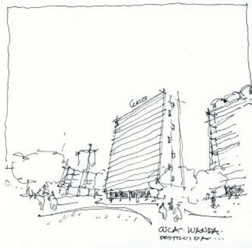
Fig. 5. "Edificio Cuca", demolido en 2011. Croquis de R. Goycoolea P., 2013
