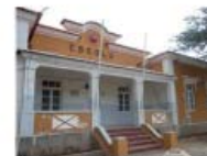
2. Escola Primária (não identificada)
