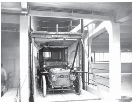
Fig. 7. Aspecto interior da garagem (in FP). Note-se as infra-estruturas eléctricas sobre a viga em primeiro plano e a plataforma hidráulica para deslocação vertical dos automóveis.
