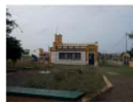
14. Posto Escolar do Bairro Craveiro Lopes, CV OP, 1956
