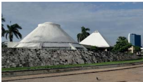
Fig. 16. Plaza Moch Couoh, en San Francisco de Campeche, México, ca. 1966, Alterada con numerosas remodelaciones que fueron desde teatros al aire libre, estacionamientos, oficinas institucionales, donde en una zona vestibular desarrolla una cubierta en forma piramidal tipo egipcia que desvirtúa el proyecto original curvilíneo manifestándose como un tipología arquitectónica que replica un elemento existente, de manera caprichosa o fundamento. Fotografía: Carlos Domínguez Vargas, 2013
