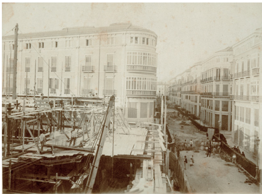
Calle Larios en construcción, AMM, 11769
