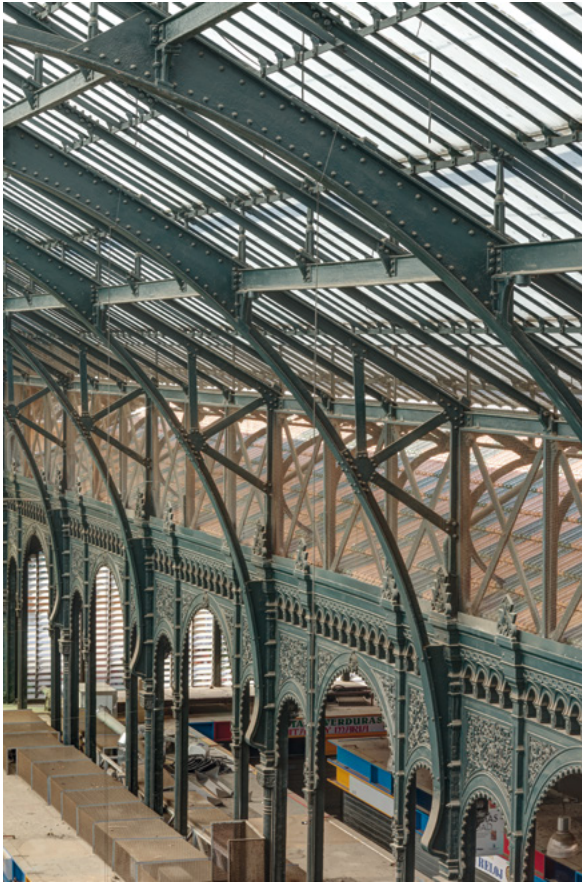
Vista interior actual tras la restauración
