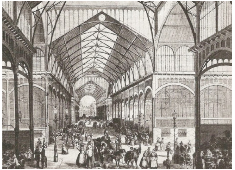
Interior de uno de los pabellones de Les Halles que asemejaban calles cubiertas acristaladas
