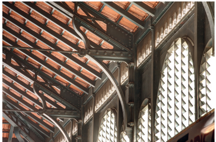
Detalles de los distintos elementos metálicos de la cubierta
