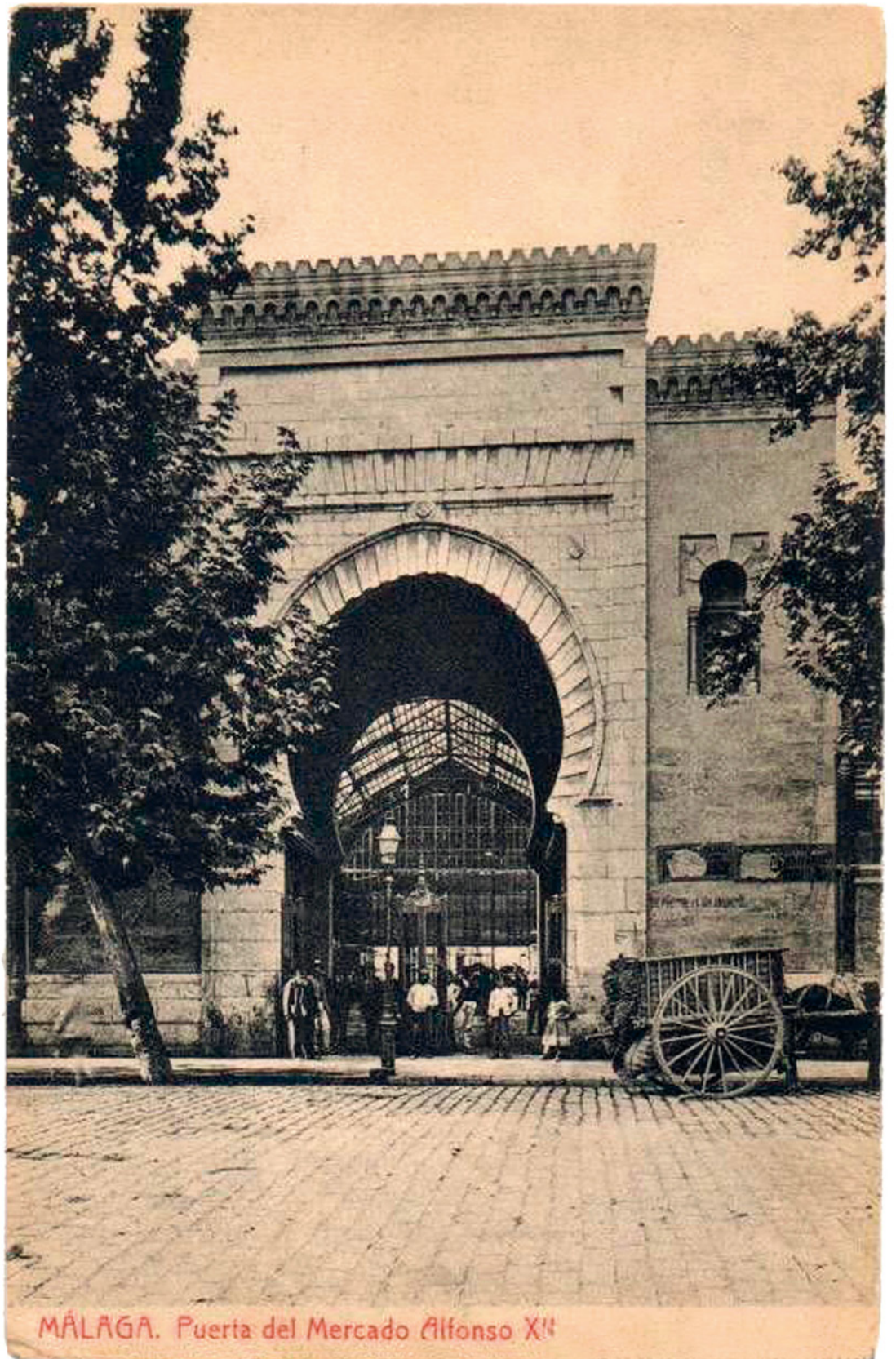
En la fotografía antigua se aprecia la iluminación interior mediante el acristalado original de la cubierta central
