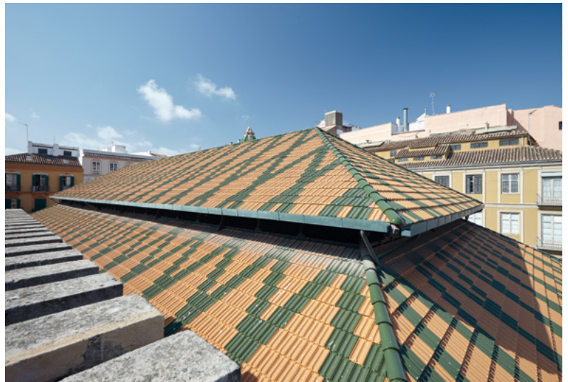
Una de las restauradas cubiertas laterales de dos alturas
