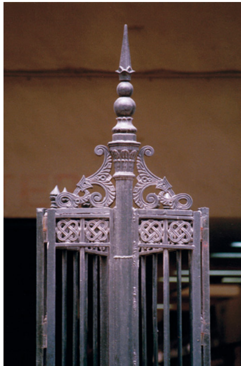
Detalle de la cancela de hierro de la entrada principal que solucionaba eficazmente el cierre del arco árabe. Fotografías, antes y después de la última restauración, en las que se aprecia la recuperación de la diaphanidad interior del proyecto original
