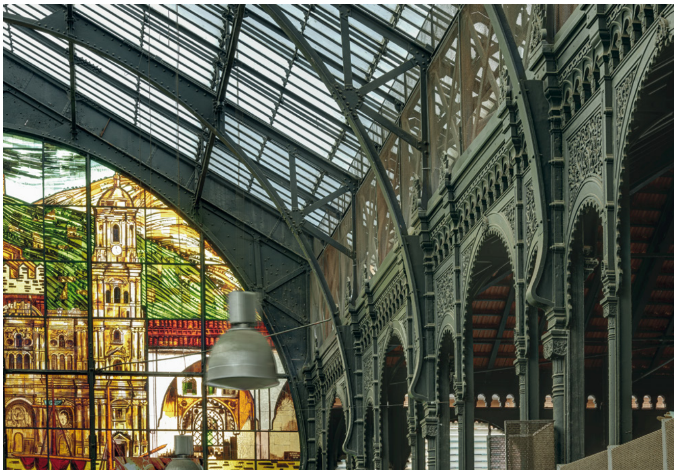
Interior después de su restauración
