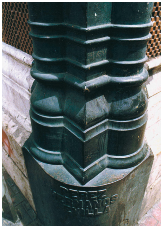
Sello del taller siderúrgico en la estructura de fundición del mercado
