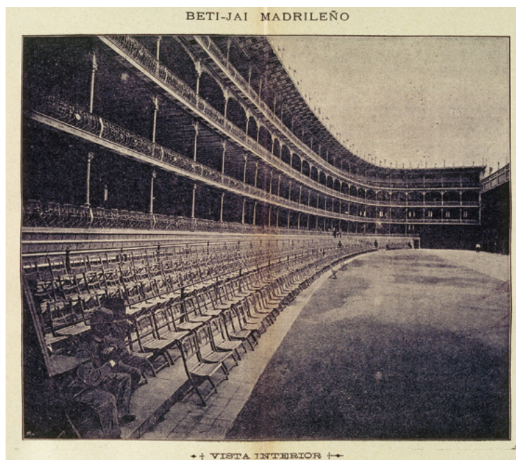
Vista de la estructura metálica del frontón
