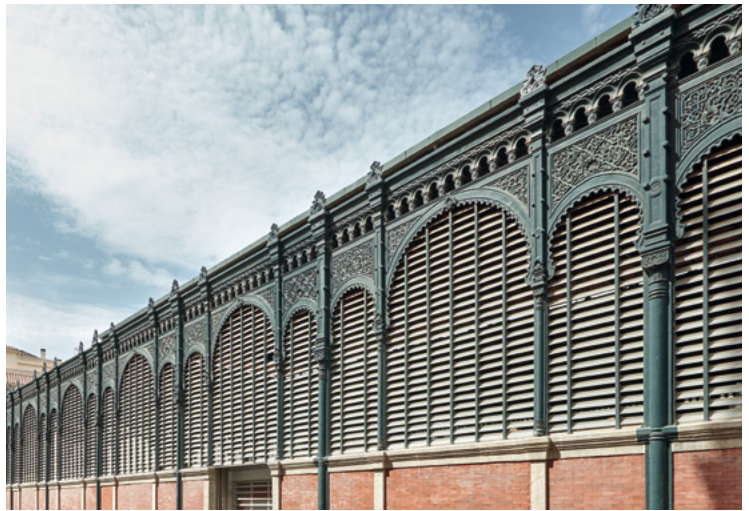
El cierre metálico de las fachadas de ritmo tripartito
