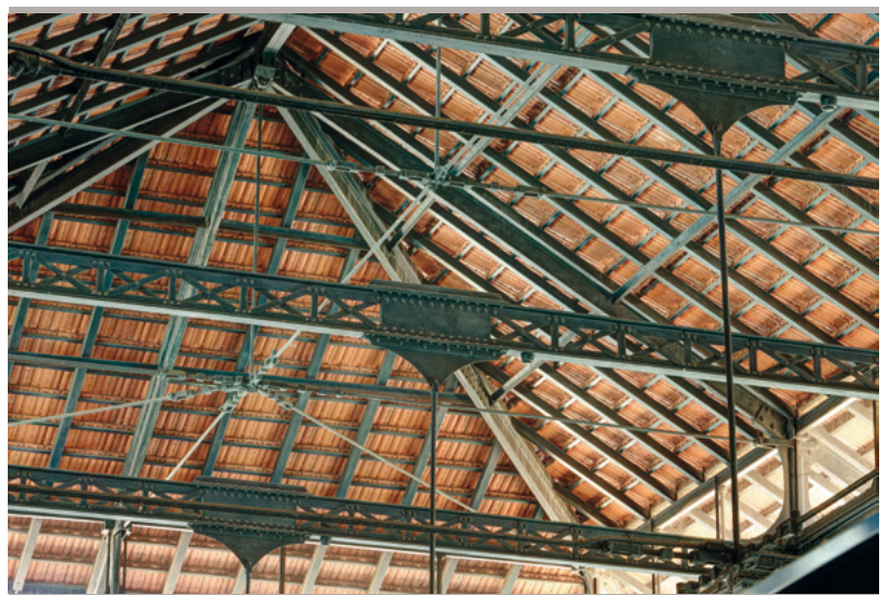
La estructura metálica de la armadura
