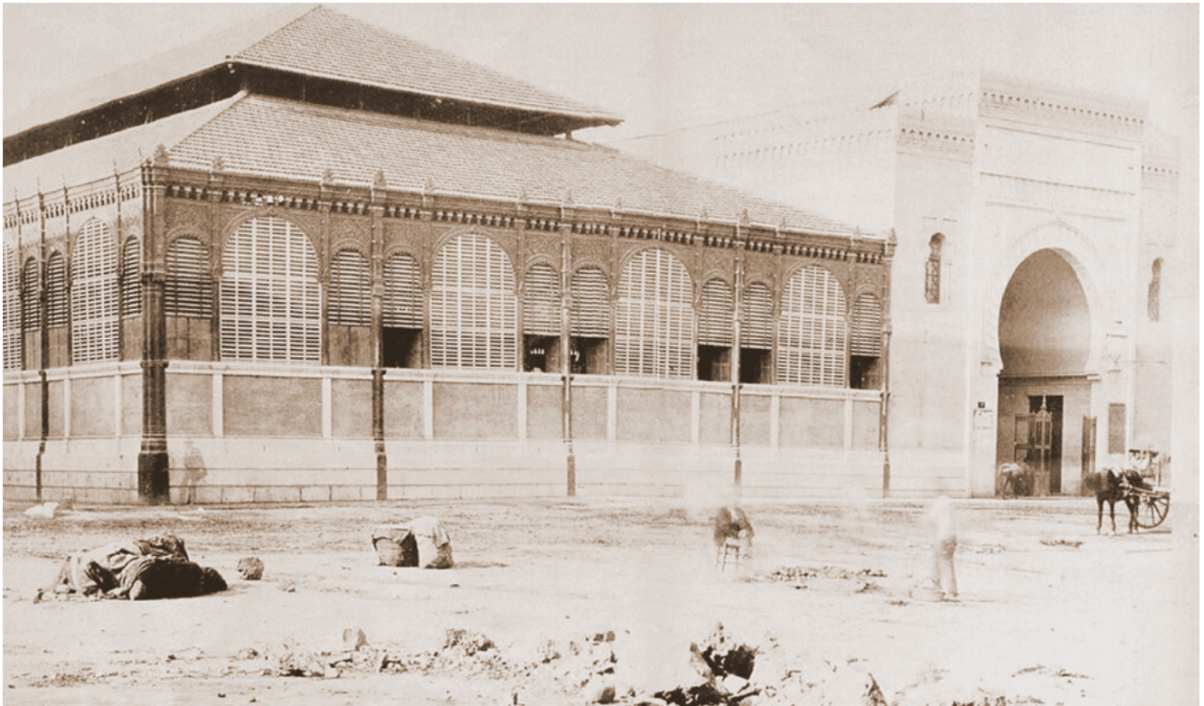
Una de las primeras fotos del mercado, aún sin acabar la pavimentación de la calle
