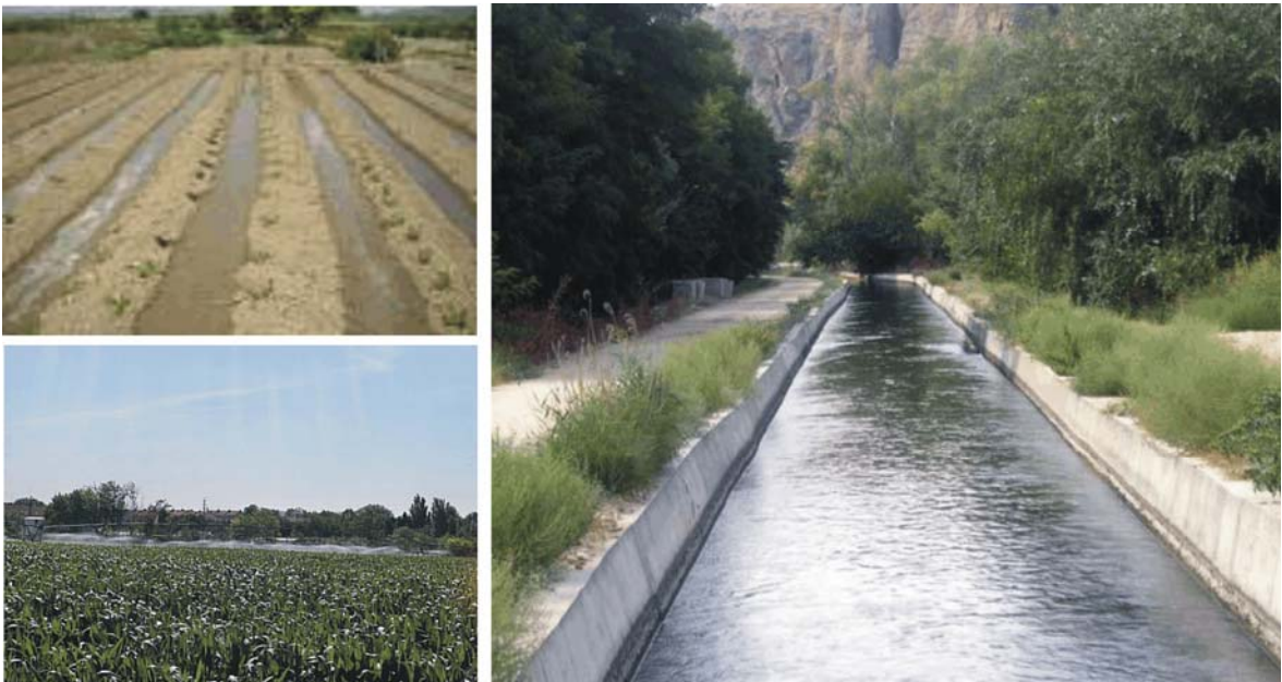
Riego en las Vegas de la Comunidad de Madrid: riego por gravedad (izquierda arriba), riego por aspersión (izquierda abajo) y vista de la Real Acequia del Jarama (derecha)
