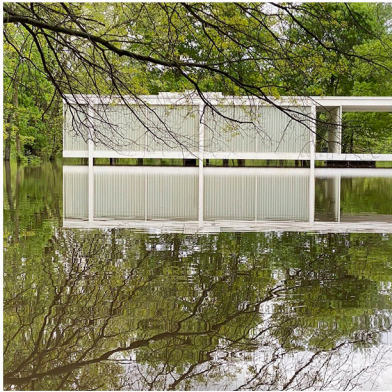
La casa Fansworth, junto al Fox river, se eleva por una condición territorial: las comunes crecidas del cauce que anegan toda la parcela.
