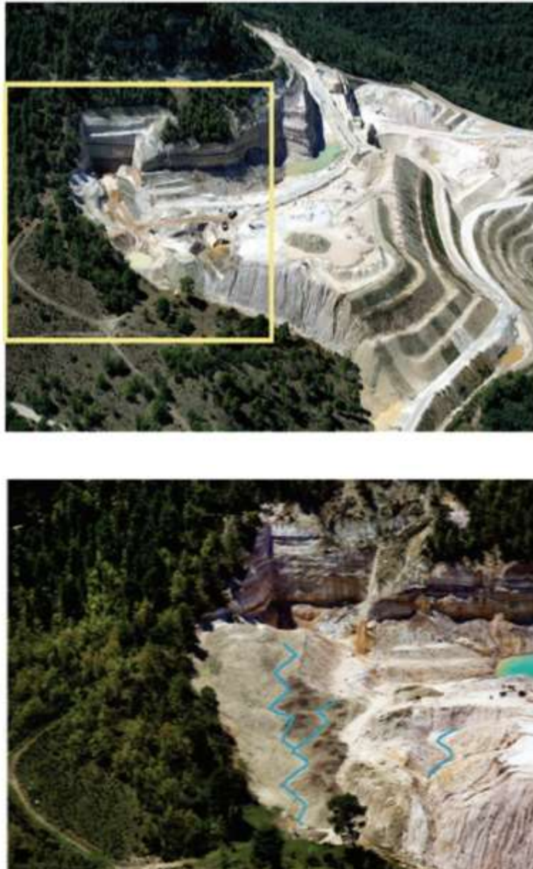
Figura 5. Arriba, vista aérea del inicio de las labores de restauración con el método GeoFluv™ de la mina El Machorro. Abajo, zona ya remodelada.
