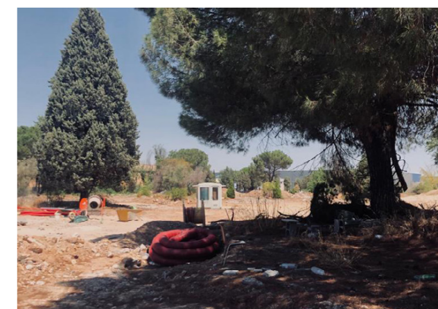
Fig. 27: Estado actual de demolición de Avon Cosmetics Fuente: Fotografía por Julio Rodríguez (2022).
