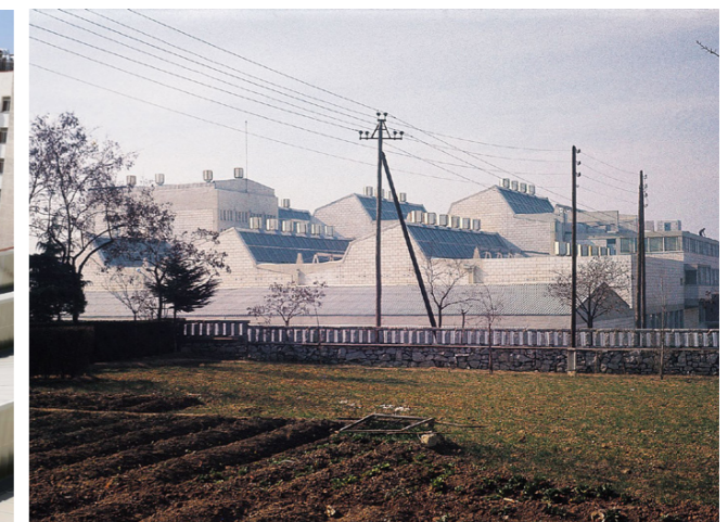
Fig. 40: Evolución de los dientes de sierra en la Central Lechera Clesa de Madrid Fuente: Fotografía anónima, extraído de la Fundación Alejandro de la Sota y del DOCOMOMO Ibérico https://docomomoiberico.com/edificios/central-lechera-clesa/
