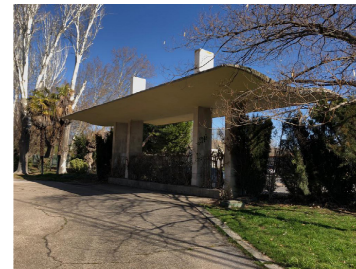
Fig. 105: Marquesina, estado actual Fuente: Fotografía por Julio Rodríguez (2022).
