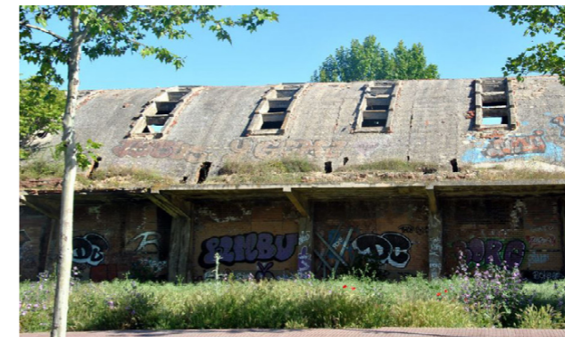
Fig. 209: Exterior de la antigua nave de Forjas, visible el voladizo Fuente: Fotografía por Félix Abánades (2014).
