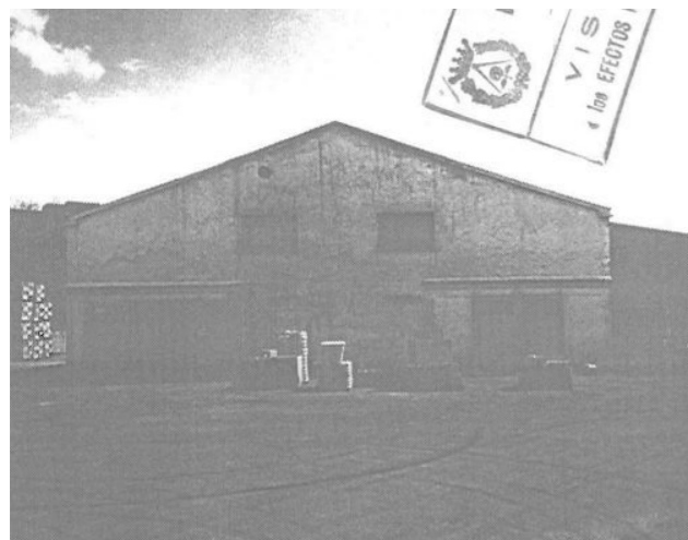
Fig. 224: De arriba a abajo: vistas desde la Carretera Pastrana, vista desde la esquina suroeste del interior de la parcela y vista del alzado norte de la nave principal donde se encontraban los hornos Hoffman Fuente: Fotografía por Genoveva Christoff Secretan (1986). Archivo Municipal de Alcalá de Henares. Leg 6403/01
