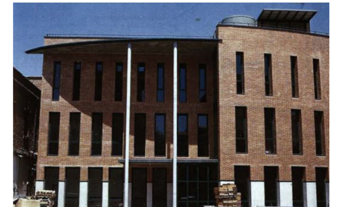
Fig. 195: Alzado sur de la escuela de idiomas, vista desde el patio Fuente: Fotografía por Artigas Patón Pina (1990).
