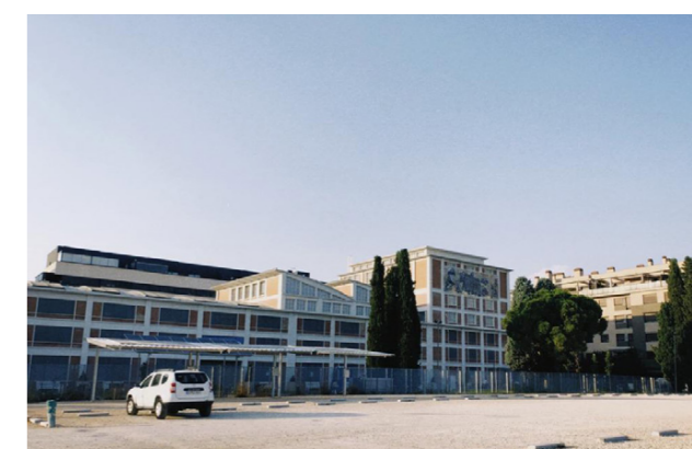
Fig. 29: Perfumería Gal, fotografía del alzado sur (actualidad) Fuente: Fotografía por Julio Rodríguez (2022).
