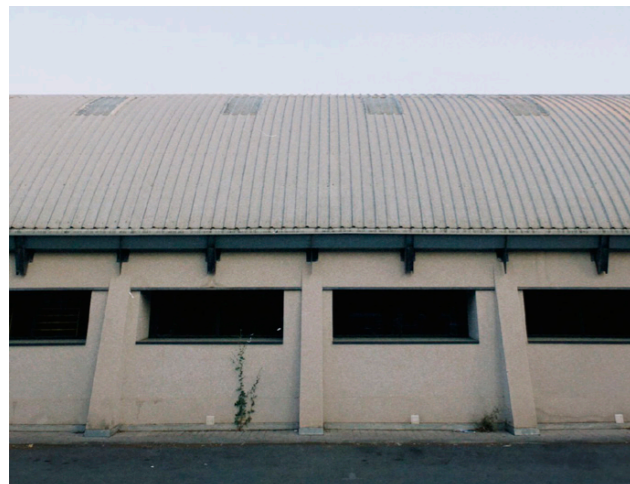
Fig. 206: Detalle de los pilares Fuente: Fotografía por Julio Rodríguez (2022).
