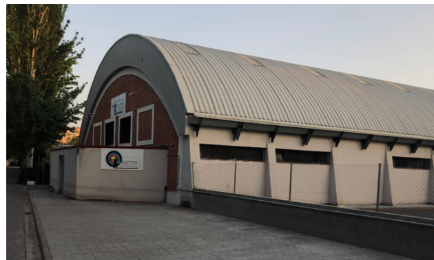
Fig. 202: Nueva nave de Forjas Fuente: Fotografía por Julio Rodríguez (2022).
