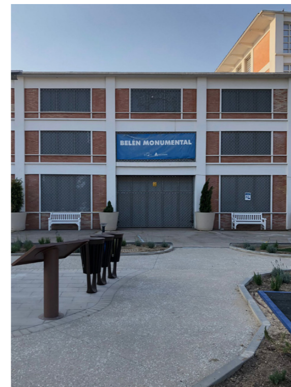
Fig. 236: Proyecto de restauración de Aranguren + Gallegos. Encaadre sobre los huecos del alzado sur Fuente: Fotografía por Julio Rodríguez (2022).
