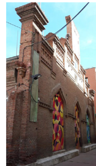
Fig. 45: Central Eléctrica Complutense. Fachada sur Fuente: Fotografía por Ángeles Layuno.
