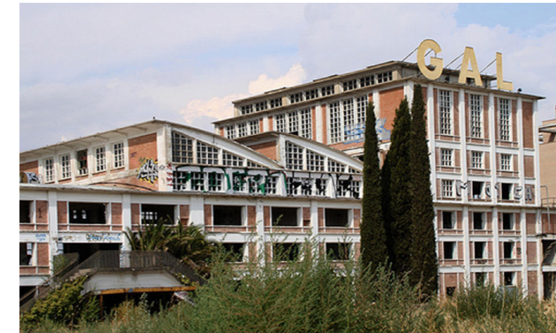
Fig. 133: Fotografía del alzado sur (2006-2011)
