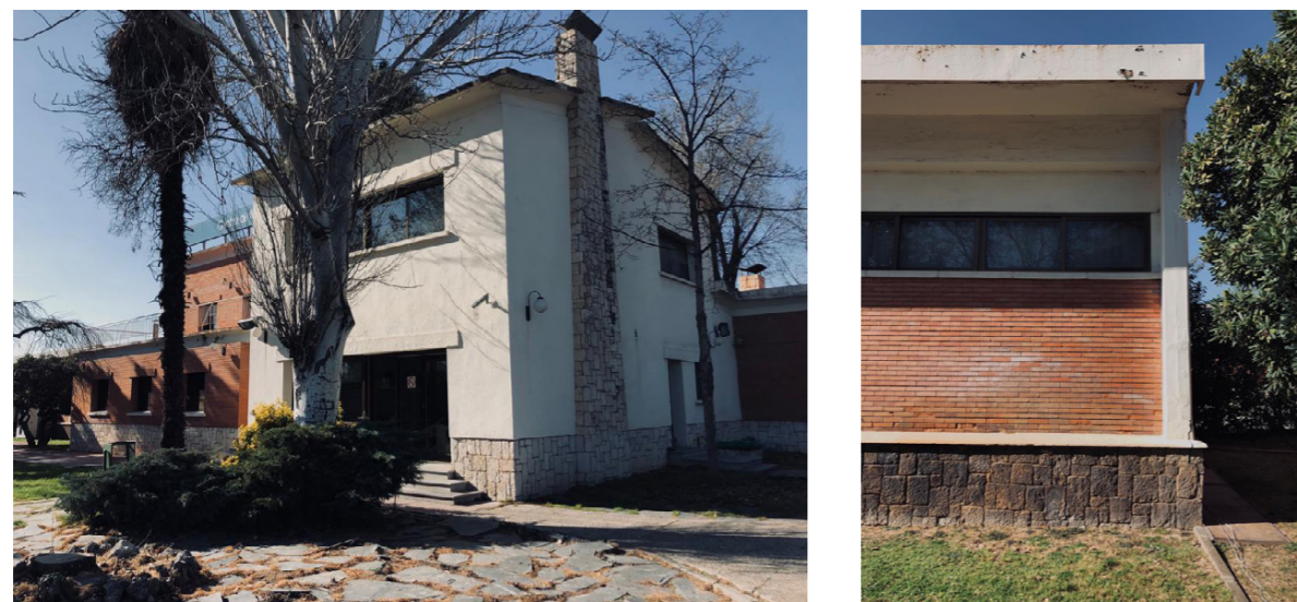
Fig. 108: Antiguo centro de formación Fuente: Fotografía por Julio Rodríguez (2022).
