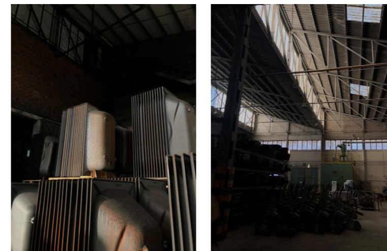
Fig. 114: Interior fábrica de bañeras, de izquierda a derecha: bañeras apiladas, detalle de cubierta con dientes de sierra y estructura metálica Fuente: Fotografía por Julio Rodríguez (2022).
