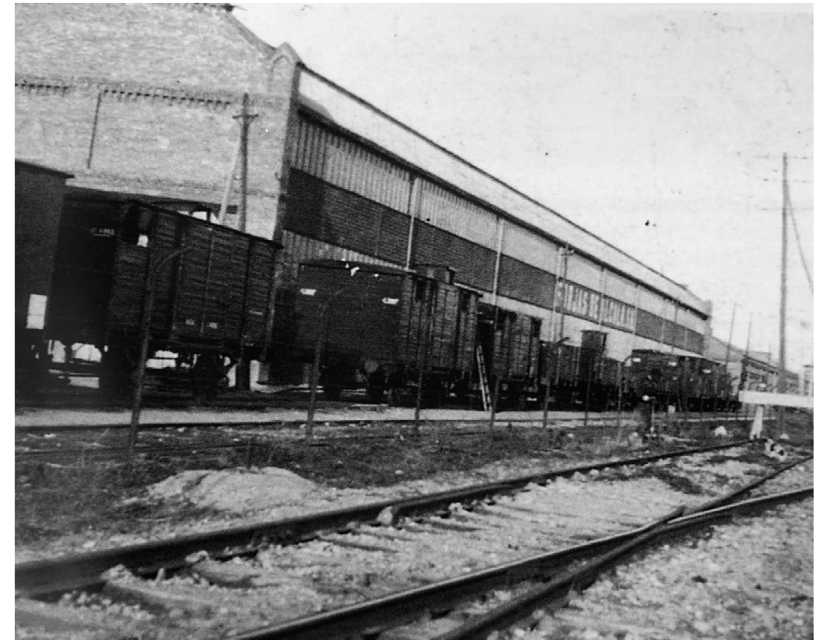
Fig. 40: Nave de montaje de la fábrica Forjas de Alcalá, imagen desde las vías del tren
