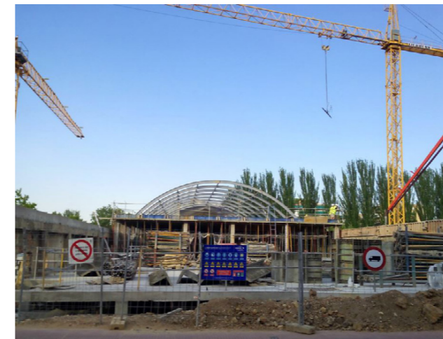
Fig. 213: La nueva nave de Forjas en construcción Fuente: Fotografía por Félix Abánades (2014).
