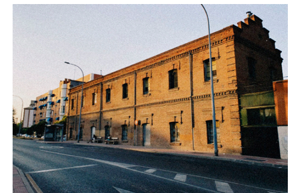
Fig. 61: Fotografía fachada oeste, silo al fondo Fuente: Fotografía por Julio Rodríguez (2022).
