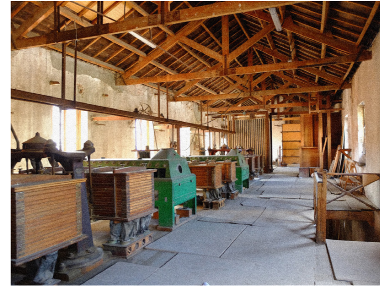
Fig. 52: Interior, planta 1 Fuente: Extraído de https://twitter.com/ppdealcala/status/1519231823984926720?ref_src=twsrc%5Etfw
