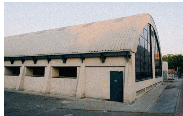
Fig. 205: Vista desde la esquina noroeste Fuente: Fotografía por Julio Rodríguez (2022).
