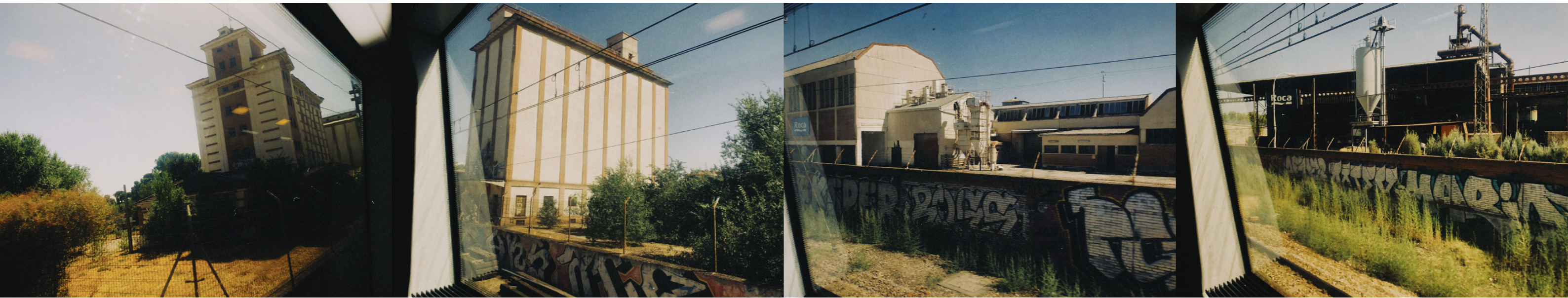
Fig. 2: Vistas desde el tren a la llegada de Alcalá. De derecha a izquierda (sentido de llegada): Fábrica de bañeras de Roca, fábrica de radiadores de Roca y los silos de Alcalá Fuente: Fotografías por Julio Rodríguez (2021).
