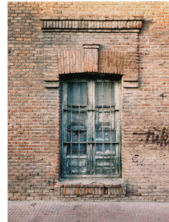
Fig. 51: Fotografía detalle hueco de planta baja Fuente: Fotografía por Julio Rodríguez (2022).
