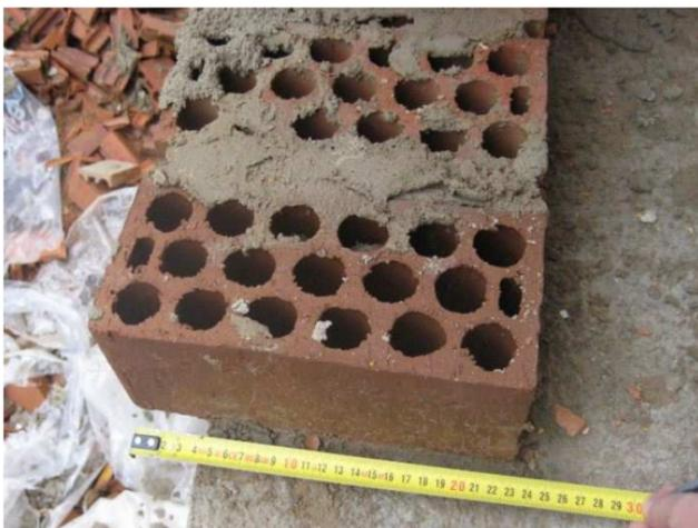
*Foto E – Hilada de arranque de fábrica de ladrillo perforado de 1 pie de espesor*
