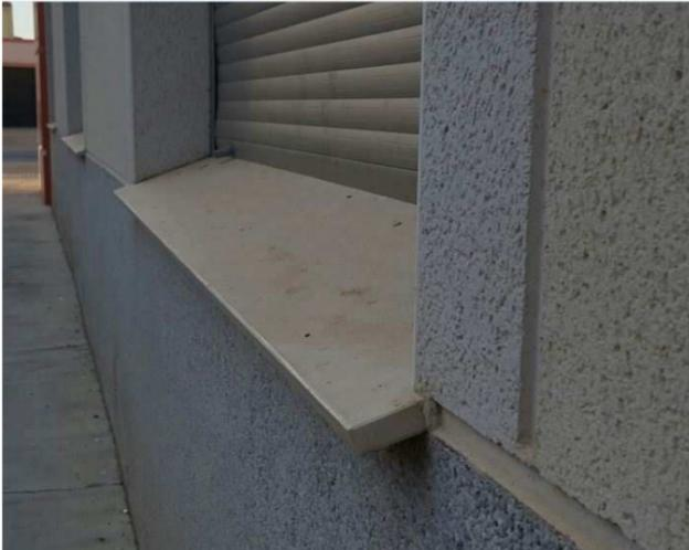
*Foto H – Vierteaguas de piedra artificial con pendiente, vuelo y entrega lateral adecuados, aunque carece de la realización de un goterón*
