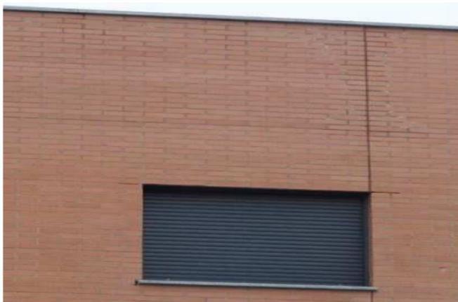
*Foto K – Junta de dilatación coincidente con la jamba de ventana.
