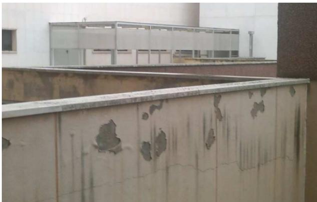
*Foto L – Peto de cubierta y colocación de vierteaguas sin pendiente ni goterón, originando la suciedad del paramento y desprendimiento de la pintura*
