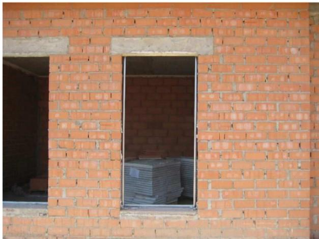
*Foto J – Formación cargadero con viguetas de hormigón en hueco de ventana con apoyos entre 10 y 20cm. Prearco de menor dimensión que el hueco*
