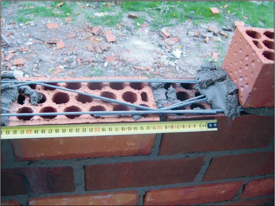
-Imagen D- Colocación de armadura en forma de celosía, en una junta horizontal de la hoja exterior de la fachada
