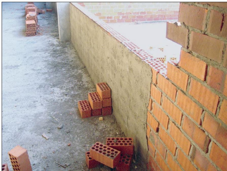
-Imagen 1- Vista interna de la hoja exterior, la cual se encuentra parcialmente enfoscada con el embastado intermedio
