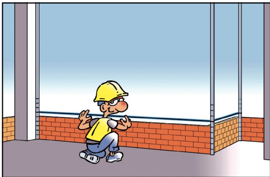
-Dibujo 4- Colocación de miras e inicio del levante de la hoja exterior
