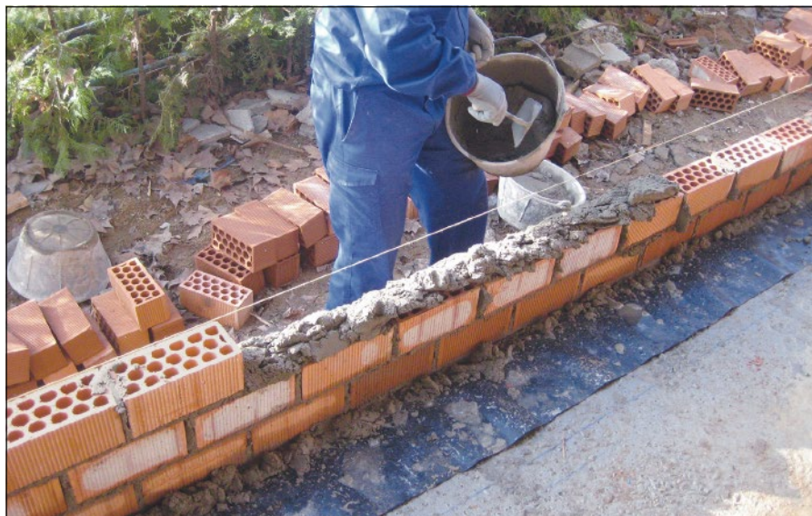
-Imagen B- Colocación de lámina impermeabilizante en el arranque de fachada en planta baja
