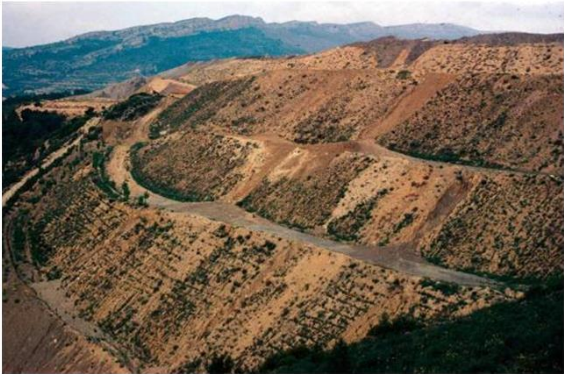
Figura 6: Bermas y los taludes (inclinación de 45º), formas de relieve características del paisaje minero.
