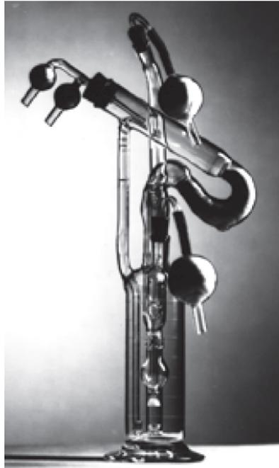
*Figura 14: bomba de perfusión desarrollada por Lindbergh, capaz de mantener una presión de perfusión (PP) continua. Año 1931. Fuente: Minnesota Historical Society.*
