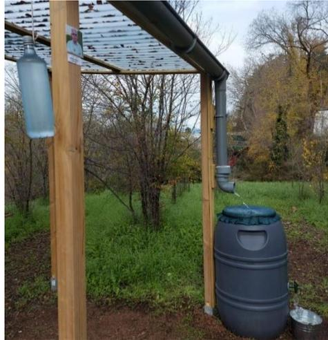
Figura 5: Sistema de recogida, filtrado y almacenamiento de agua de lluvia en tejados [17][18]
