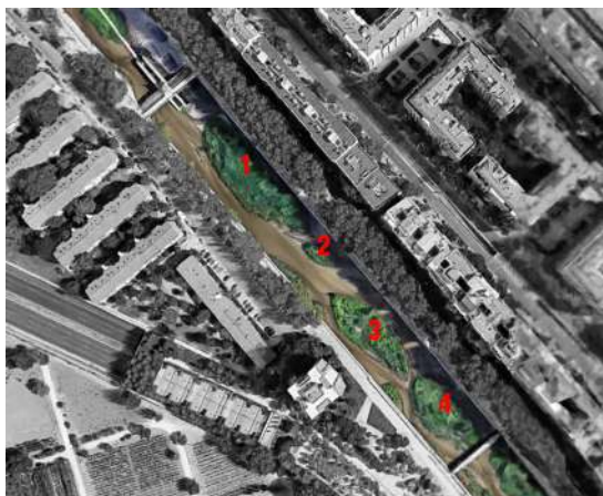
Vista aérea del tramo del río en su estado actual
