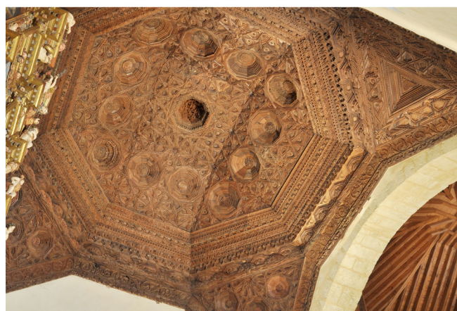
Figura 2. Artesonado de San Esteban (Villamayor de Campos). Arriba: Estado del extradós durante la restauración llevada a cabo en 2000-2010. Imagen cortesía de la empresa restauradora Rearasa S. A. Abajo: Intradós del estado actual del artesanado. Se muestra parte del retablo.
