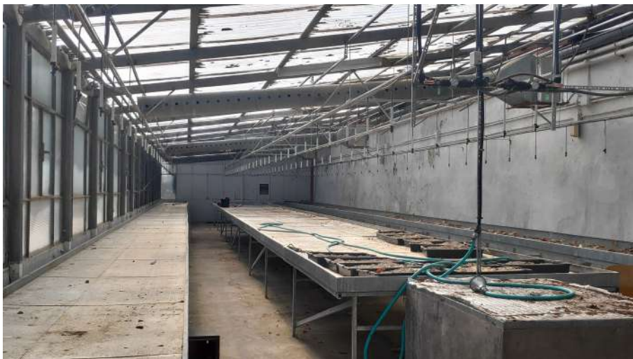
Zona Norte de la construcción del vivero
