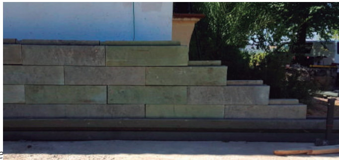
Detalle colocación bloque – viga, y 5. Imagen 10. Detalle inicio de muro. Bloques no estructurales sobre bloque estructural. Ronda, Málaga. Fuente: Llanos, Fernando. Creador del sistema Bloqueplás. 2019
