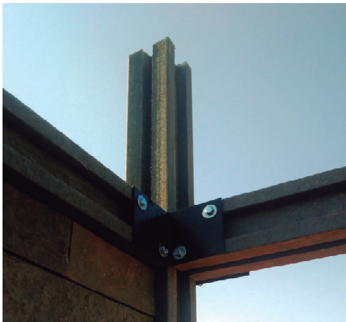
Imagen 7. Visita obra. Detalle de instalación de cubierta a dos vertientes. Elevación a partir de viga. Lepe, Huelva. Fuente: elaboración propia
