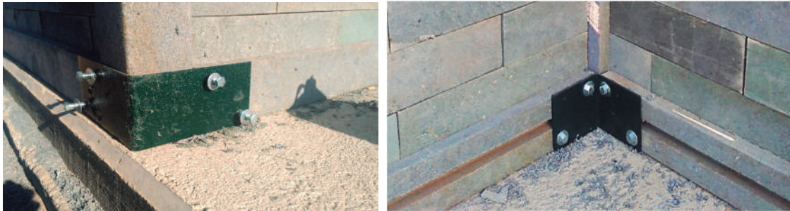
Imagen 2. Ejemplo instalación de pletina metálica. De izquierda a derecha: cara exterior intersección viga - pilar - viga; cara interior, intersección viga – viga. Fernando Llanos. Fuente: 2019. Elaboración propia
