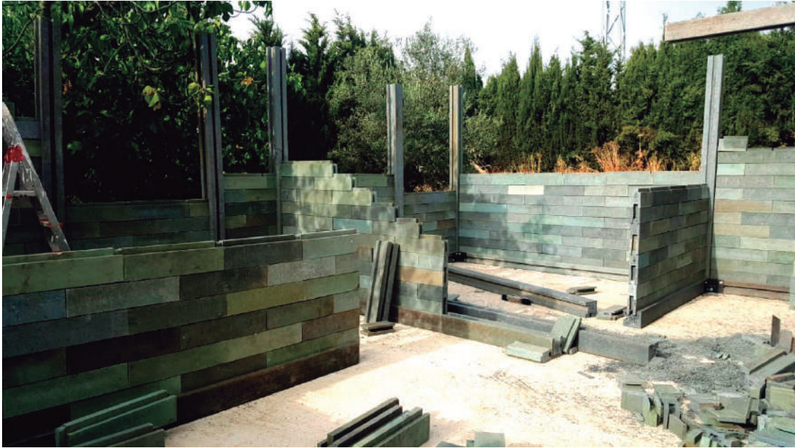
Imagen 11. Colocación de pilares a partir de la quinta hilada del muro. Ronda, Málaga. Fuente: Llanos, Fernando. Creador del sistema Bloqueplas. 2019
