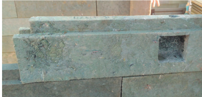
Imagen 64. Visita obra. Detalle hueco instalación de electricidad. Lepe, Huelva. Fuente: elaboración propia.
