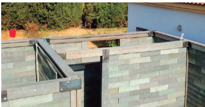
Imagen 12. Vista superior, anclado de vigas a pilares a partir de pletinas metálicas. Ronda, Málaga. Fuente: Llanos, Fernando. Creador del sistema Bloqueplas. 2019
