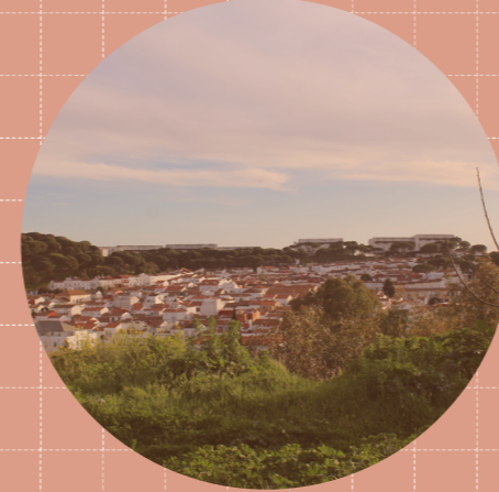
Municipio de Minas de Riotinto. Foto desde la barriada de Alto de la Mesa. El municipio cuenta con una población de unos 4500 habitantes.
