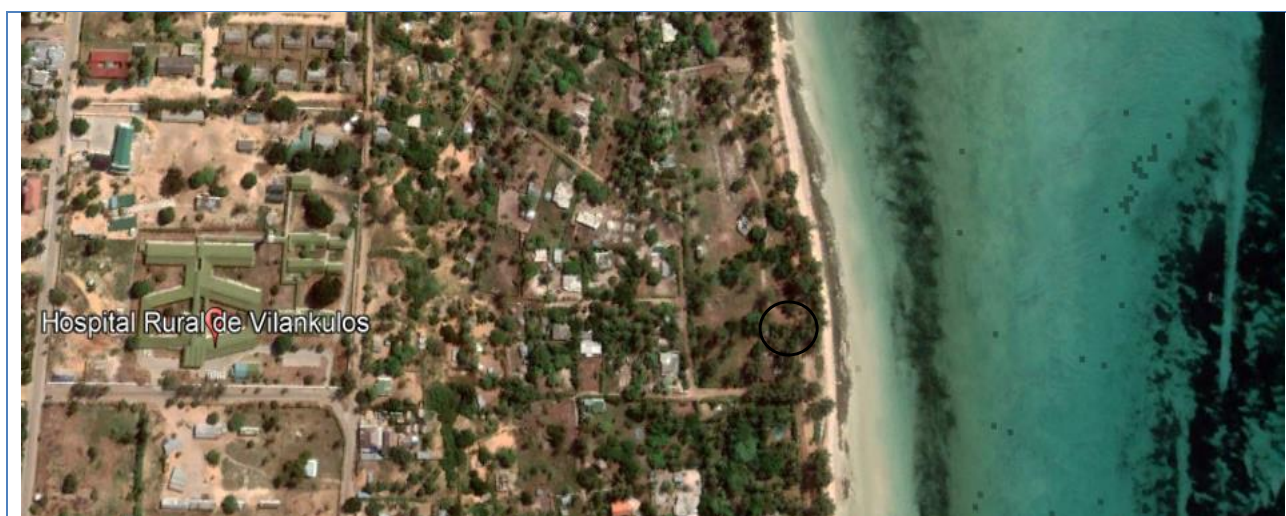
Foto 32 : Vista aérea del Hospital rural de Vilankulos, Google Earth, (2020)
