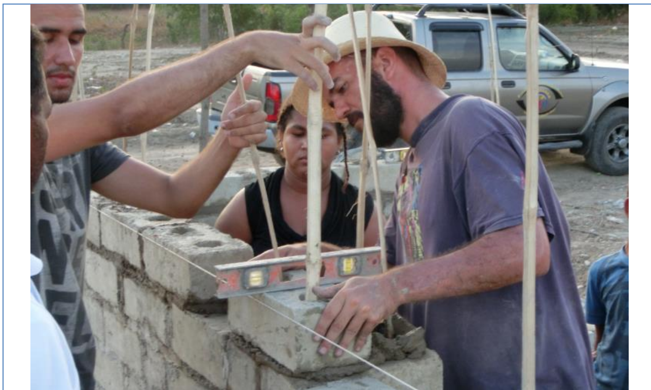
Foto 20: Construcción sismo resistente construida con Bloque de Tierra Compactada armado con caña, desarrollada por ASFE en Azua, R.D. Pérez C., (2017)
