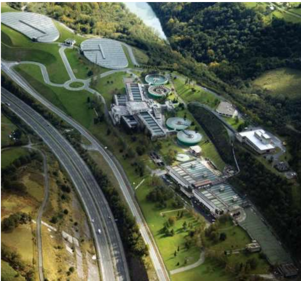
Figura 2. Vista aérea de la ETAP de Venta Alta, Arrigorriaga (Tomado de www.bizkaia21.eus )
