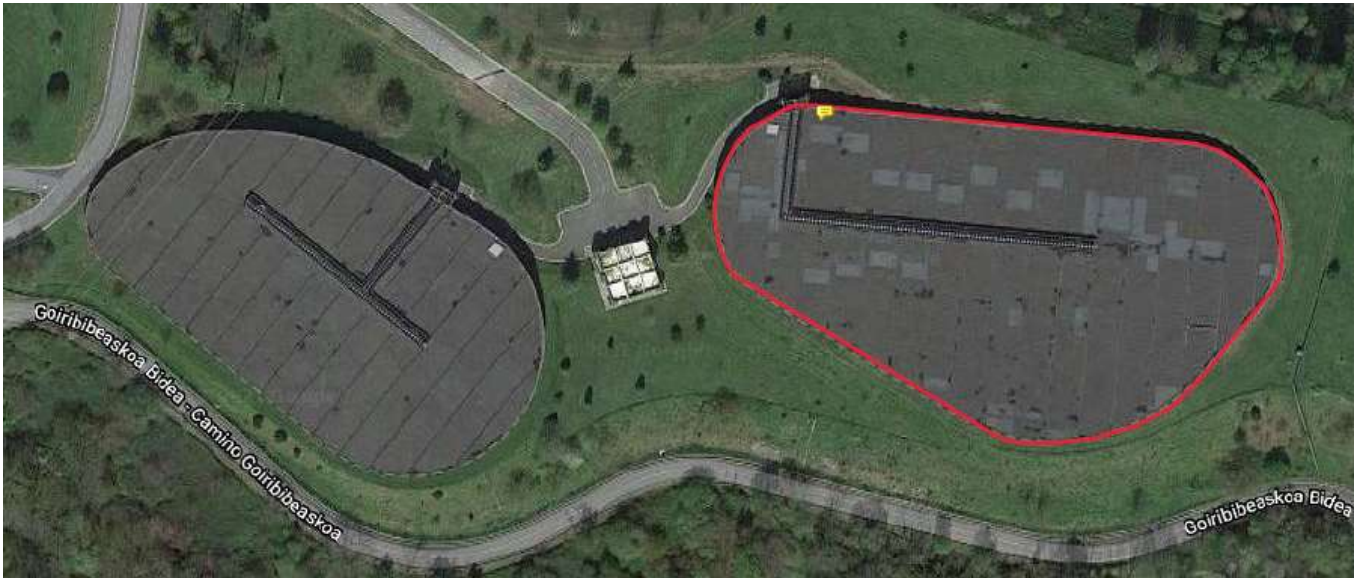
Figura 5. Vista aérea de la cubierta del depósito (Adaptado de www.google.es/maps )
