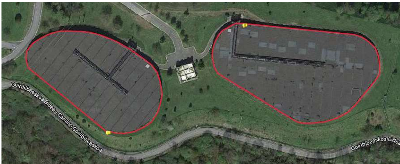
Figura 6. Vista aérea de las cubiertas de los depósitos (Adaptado de www.google.es/maps )
