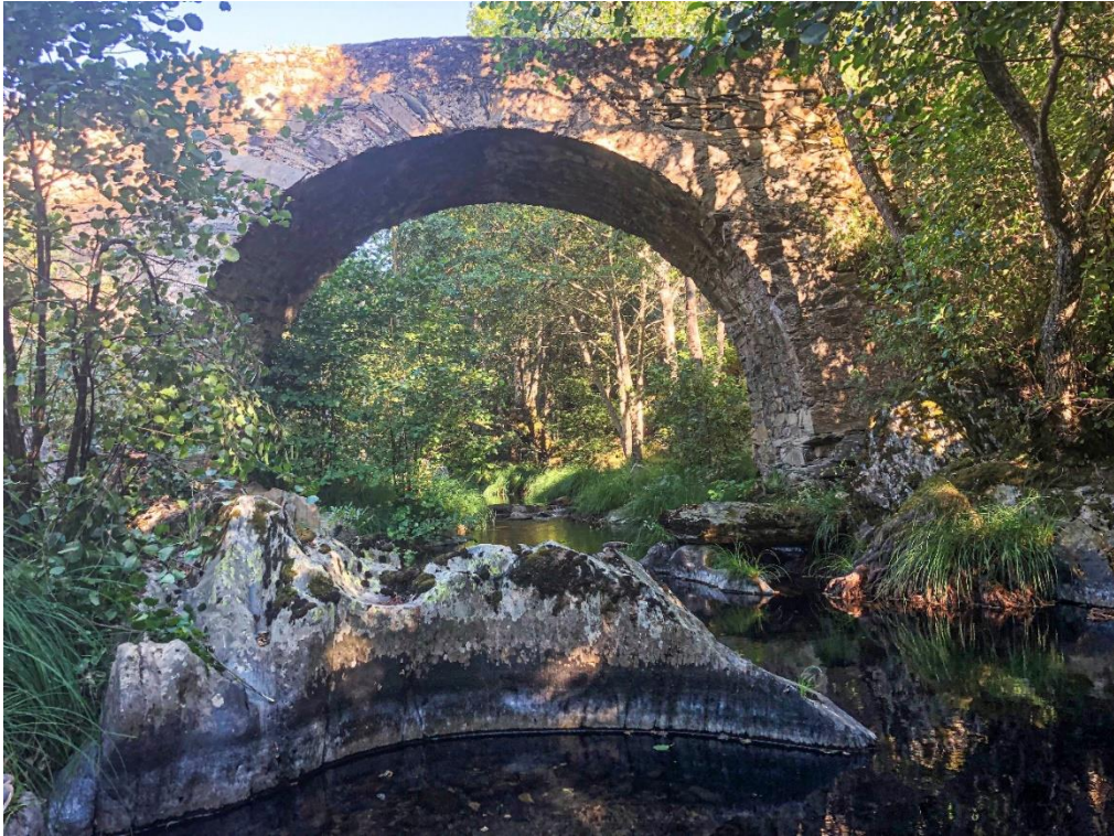
Figura 51. Uno de los denominados “puentes romanos”. Fotografía propia tomada en julio de 2020.
