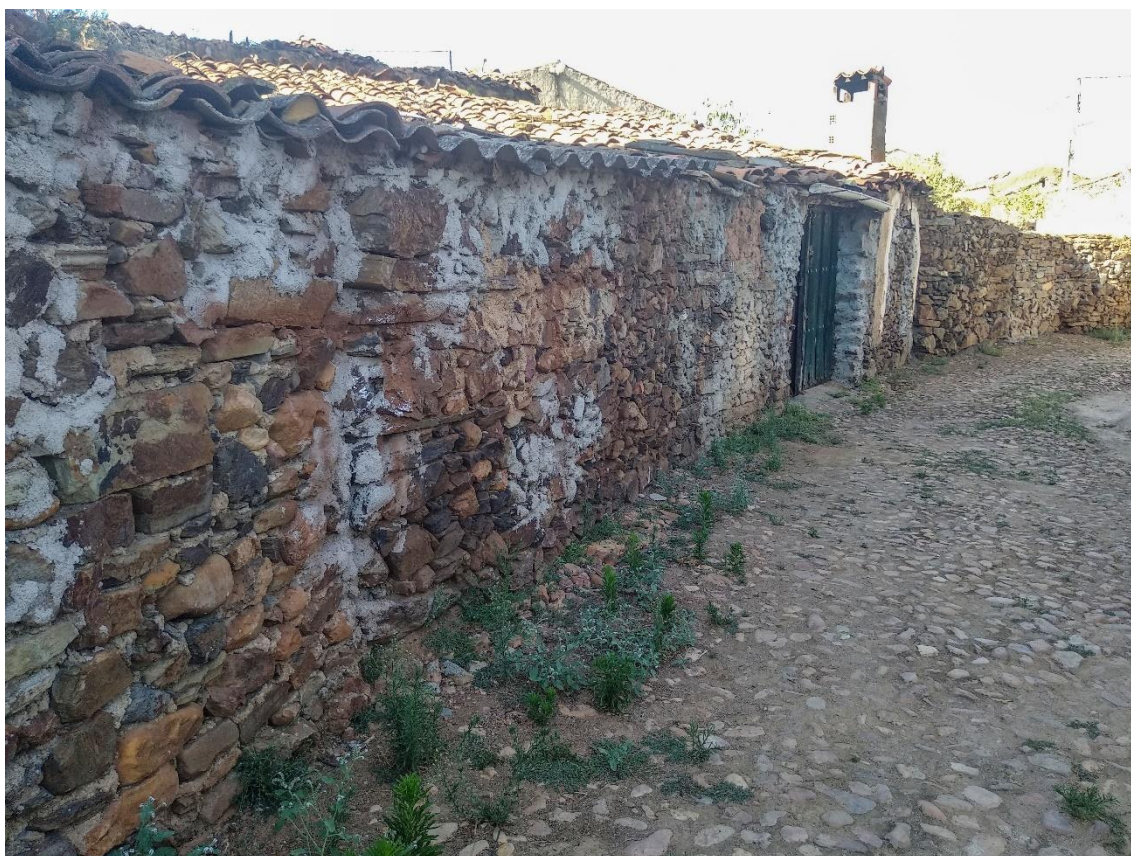
Figura 36. Calle de Serradilla del Llano con empedrado antiguo. Fotografía propia tomada en julio de 2020.
