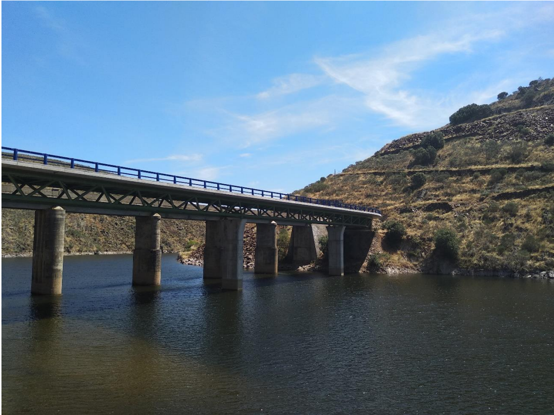
Figura 18. Mismo lugar que en la Fig. 17 , sin el puente de 1870, con el agua mucho más crecida. Aquí se aprecian el segundo puente construido en el siglo XX y un tercero del XXI, con pasarela azulada. Fotografía propia tomada en julio de 2020.
