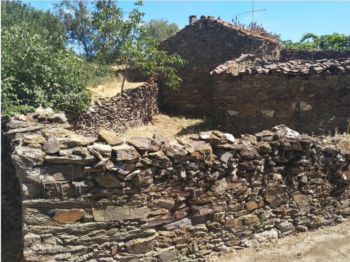
Figura 26. Conservación de algunas fachadas y paredes antiguas en Zamarra, posiblemente del siglo XIX, como ocurre, en general, en Los Agadones. Fotografía propia tomada en julio de 2020.
