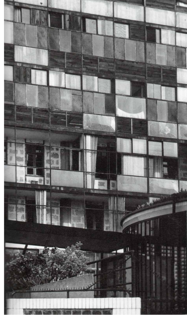
A la derecha, detalle de la fachada sur tras el impacto de la bomba. Imagen tomada de Taylor 1987.
