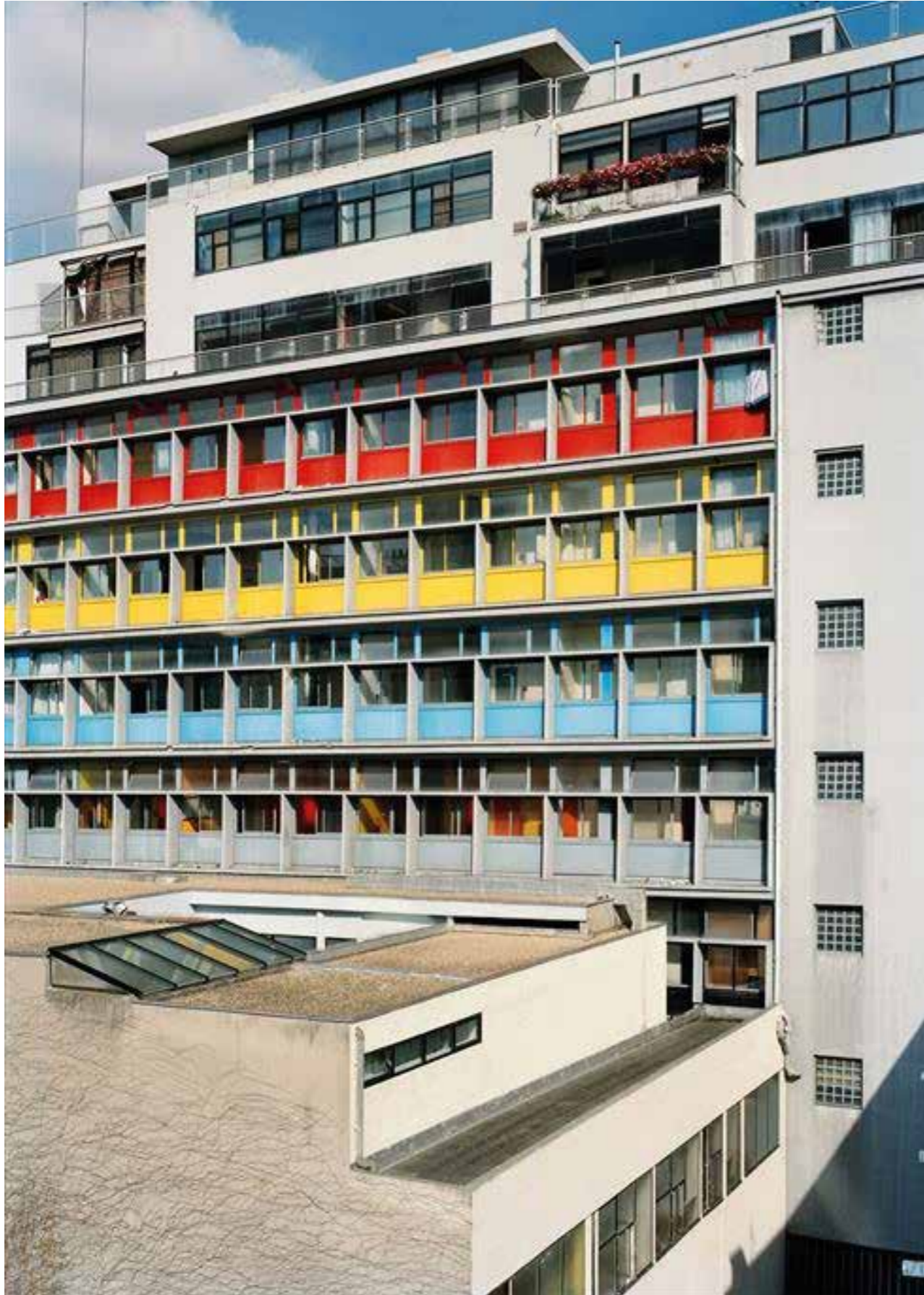
FACHADA SUR CON BRISE-SOLEIL. En la foto se pueden apreciar las ventanas de las oficinas de consulta en el volumen de recepción y las ubicadas en el volumen principal sobre el patio colindante. Al parecer, estas últimas están hechas con ladrillos de vidrio, que no permiten conexión visual, con lo que quizás esta sea la razón por la cual se permitió hacerlas.
