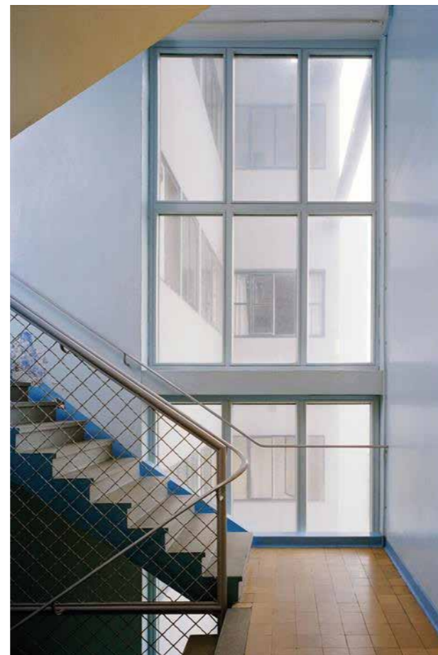
Foto del pozo de luz de las escaleras. Olivier Martin-Gambier, 2005. Tomada de la Fundación Le Corbusier: https://bit.ly/3l4PuqT
