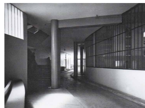
Foto del paso cubierto en el sótano -1. Tomado de Ragot y Chadoin 2016, 71.
