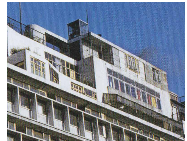
Foto ampliada del brise-soleil "blanco" fotografiado por Bernhard Hoesli alrededor de 1961. Imagen original tomada de Ragot y Chadoin 2016, 113.
