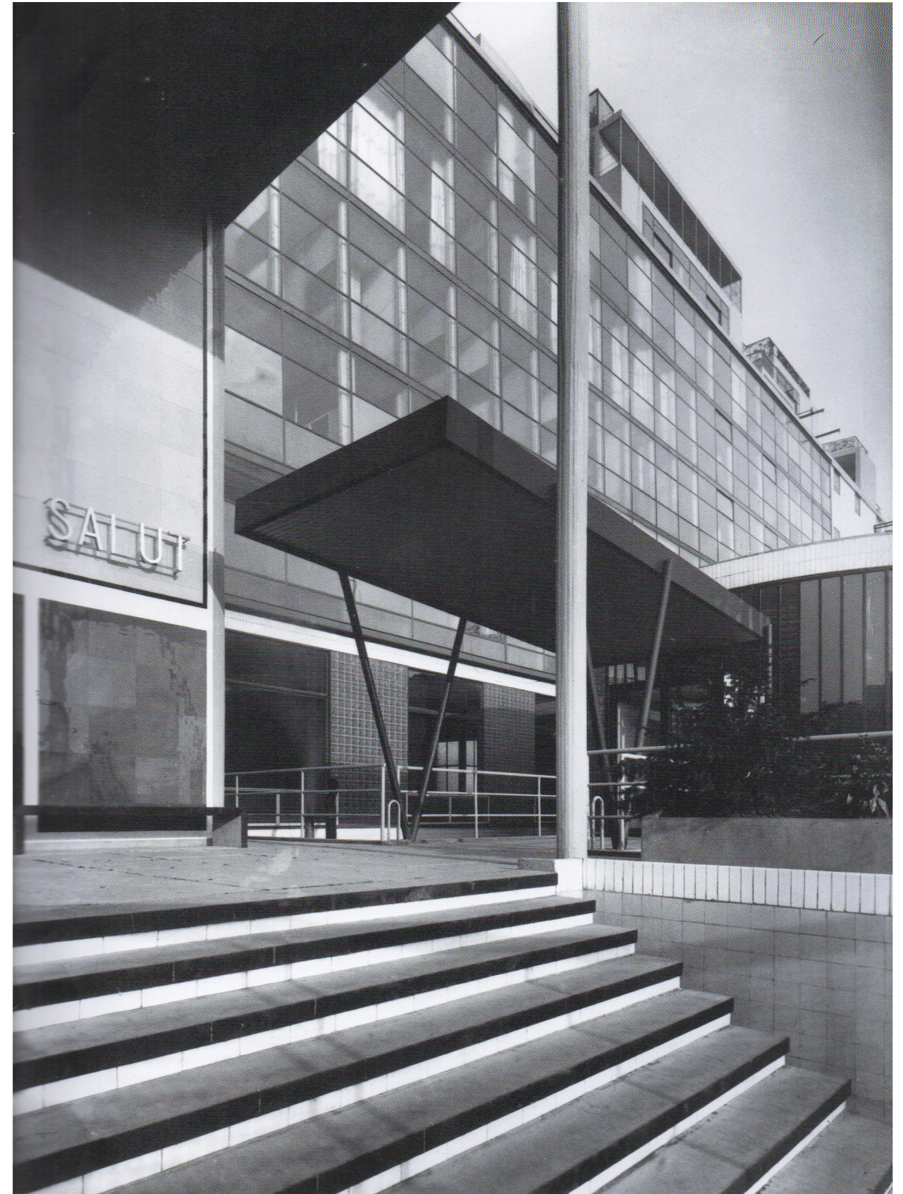
Foto de las escaleras de entrada a la Cité de Refuge alrededor dde 1933, tomada de Ragot y Chadoin 2016, 69.
