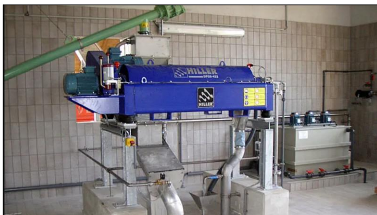
Figura 7 Equipo Centrifuga para uso en el Espesado y Deshidratado Línea de Fangos. Fuente: Catalogo de equipos empresa Hiller
