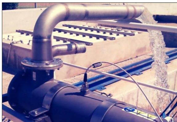
Figura 9 Reactor de dióxido de titanio , para efectuar desinfección por oxidación avanzada Fuente: Empresa H 2 O Titanium.
