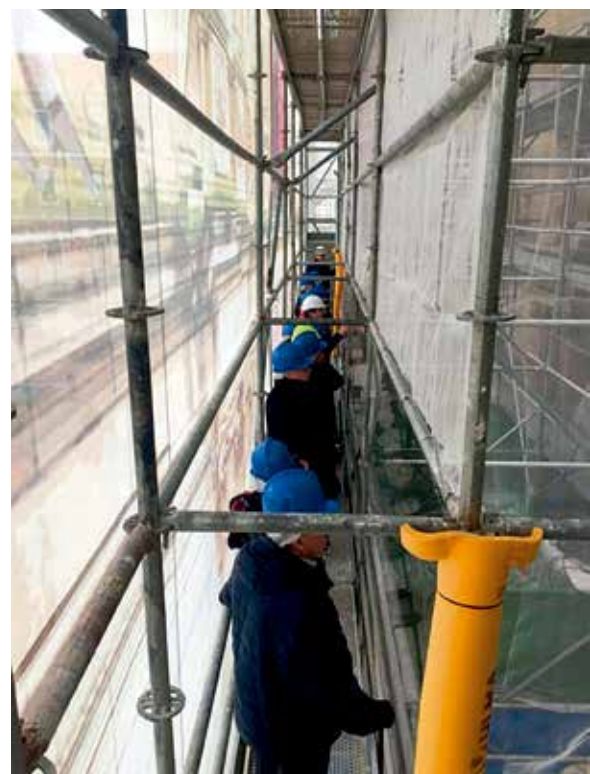
Fig. 2. Doble andamiaje. Programa “Abierto por Obras”. Fuente: Elaboración propia.
