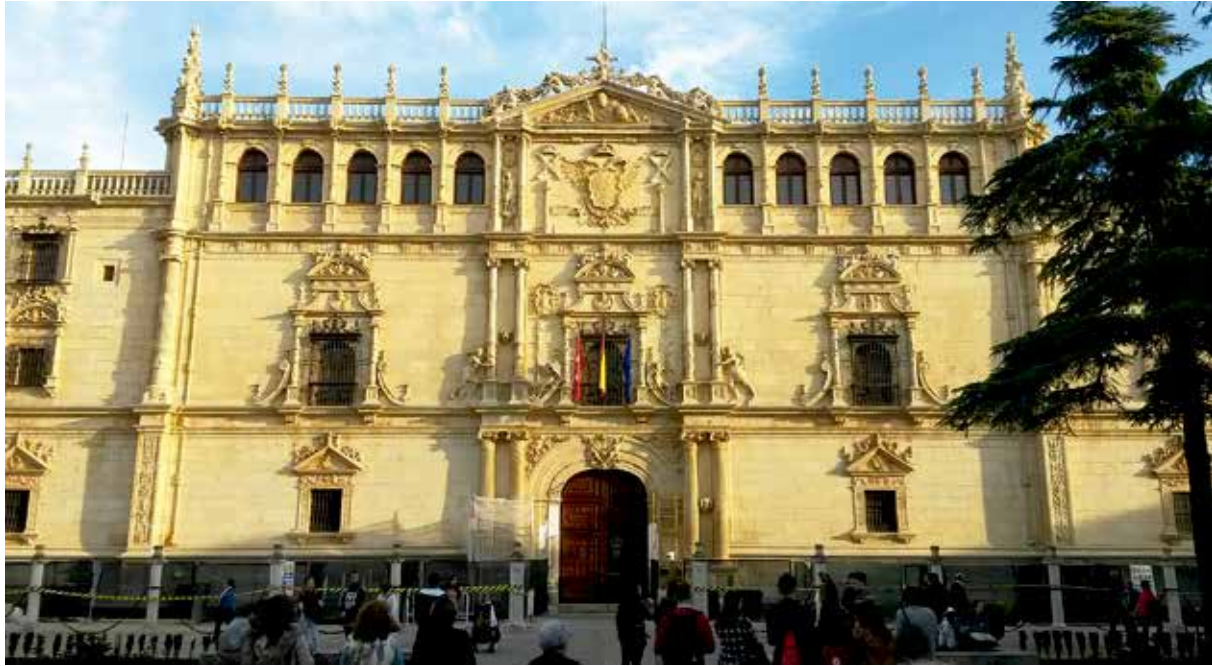
Fig. 4. Estado final, tras la retirada del sistema de andamiaje. Fuente: Elaboración propia .
