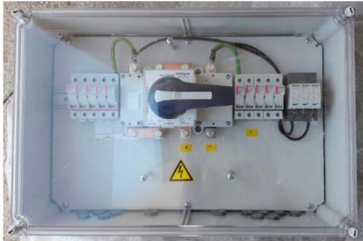
Ilustración 32. Ejemplo de cuadro de nivel I (Fuente: https://www.ambgreenpower.com/ )
