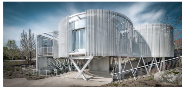
Figura 1_Exterior de la vivienda Fotografía de Imágen Subliminal
