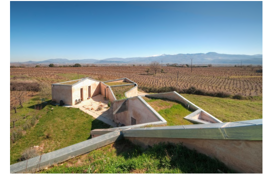
Figura 1_Imagen desde la cubierta Fotografía original del proyecto
