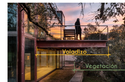
Figura 5_Terraza principal en voladizo Esquema del autor sobre fotografía original del proyecto
