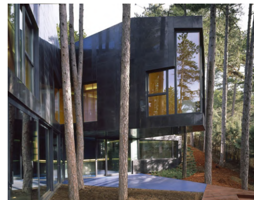
Figura 10 _ Vista exterior Fotografía original del proyecto
