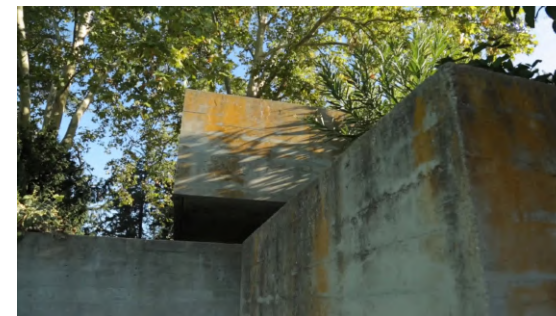
Figura 10_Muro perimetral Fotografía del vídeo sobre la casa
