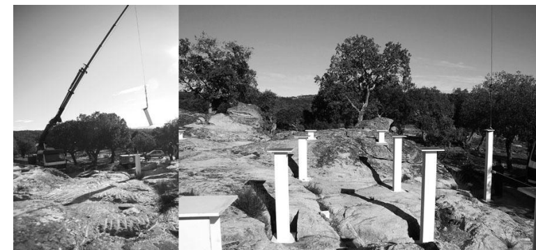
Figura 3_Pilares metálicos. Base estructural de la vivienda Fotografía original del proyecto
