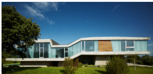
Figura 7_Vista exterior_Fotografía original del proyecto
