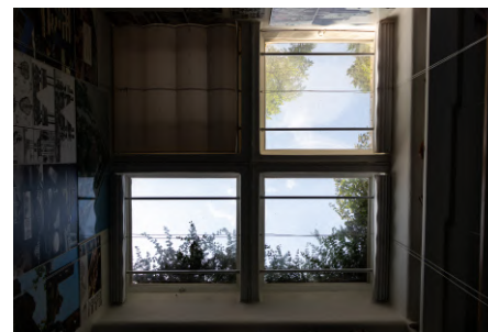
Figura 12_Vista inferior de las claraboyas Fotografía del autor
