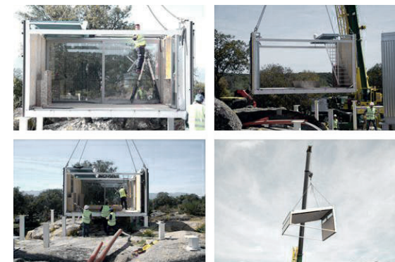
Figura 2_Proceso de montaje prefabricado Fotografía original del proyecto
