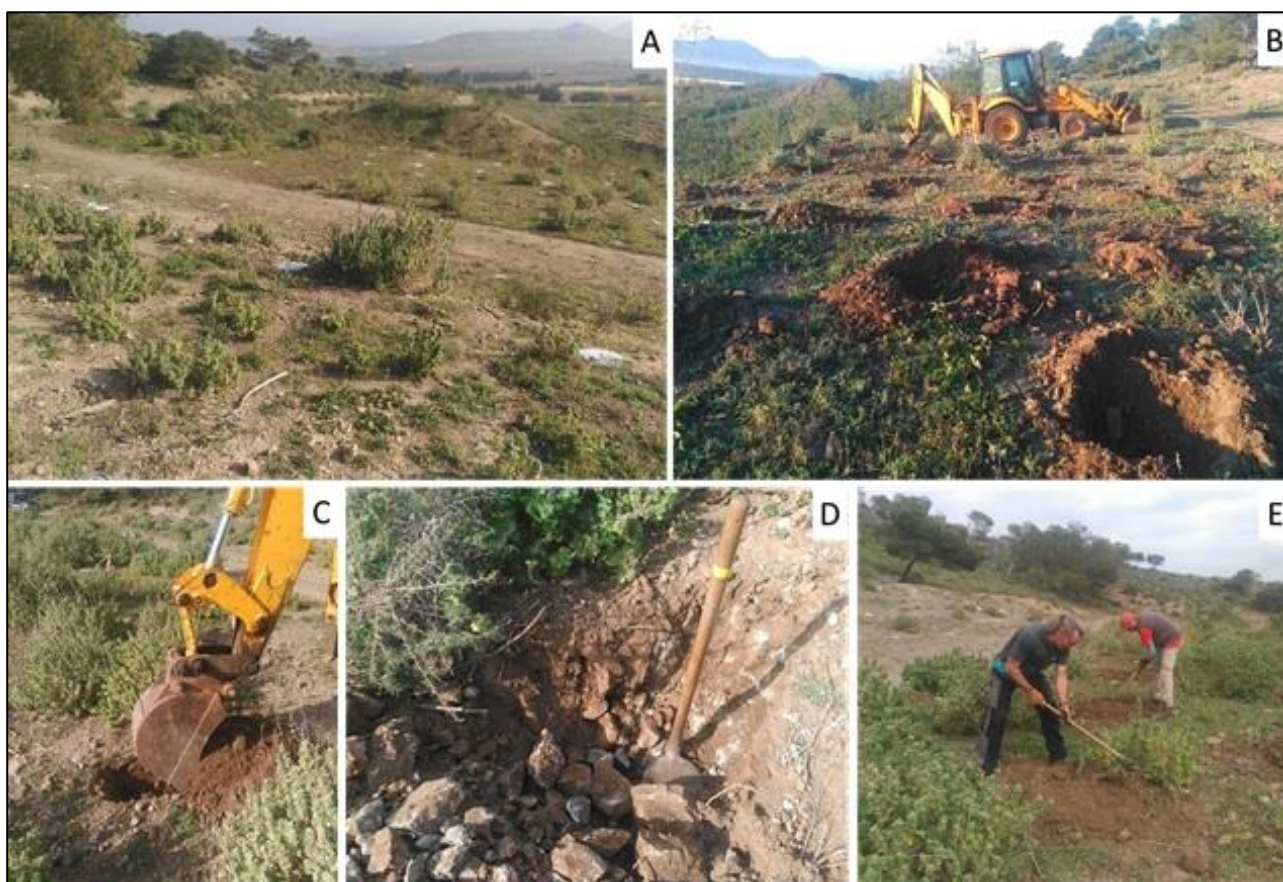
Figura 3.4.4-1: Replanteo de los sitios de ahoyado en la cara sur del CV (A). Ahoyado con retroexcavadora (A/C). Suelo superficial con exceso de roca (D). Preparación manual de hoyos tras el ahoyado mecánico (E). Fotos: propias y Fundación Sierra Minera.
