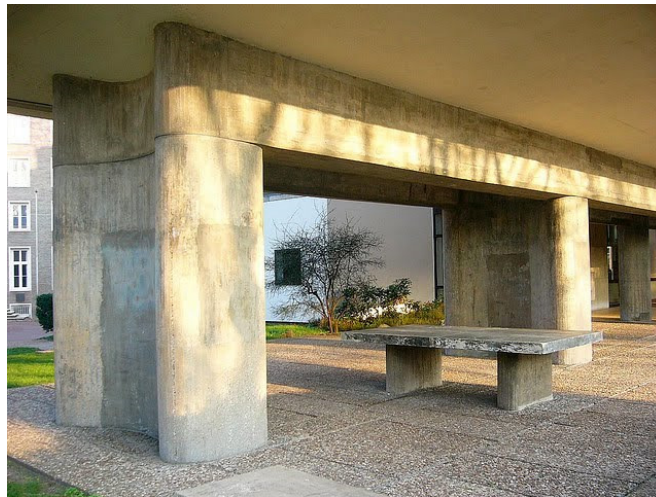
Figura 1.7. Soportes de hormigón armado en el nivel inferior del Pabellón Suizo. www.disenoyarquitectura.net
