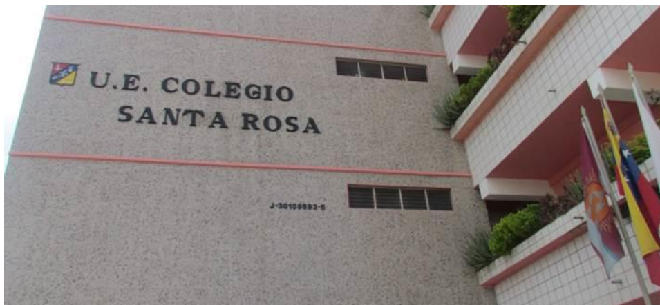
Imagen n° 1. Fachada del edificio de Primaria.
