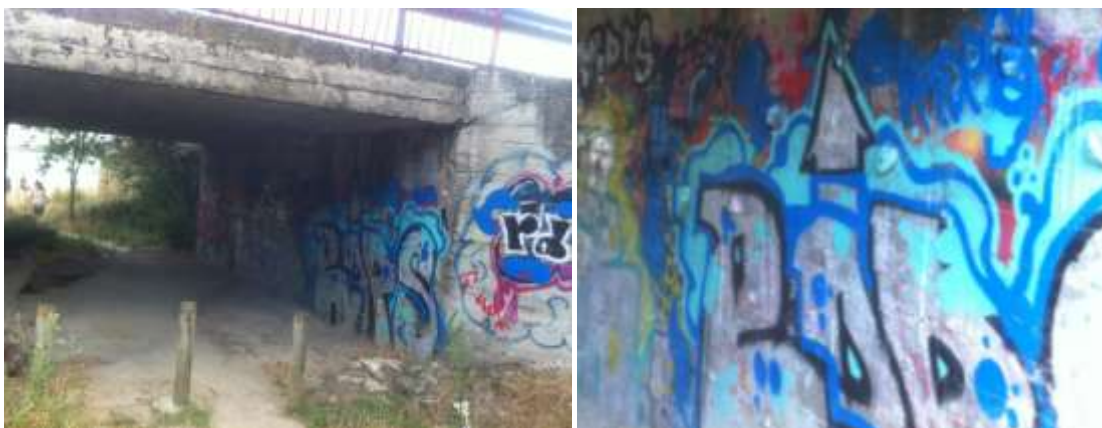
Fig.185. Un lugar de encuentro secreto bajo un puente; un espacio que los adolescentes se han habilitado para protegerse del frío y del sol y donde quedar. En la pared hay presas de escalada que los chavales que utilizan este escondite han instalado allí. (Fotografía en Manzanares el Real de M. Ramón.)
