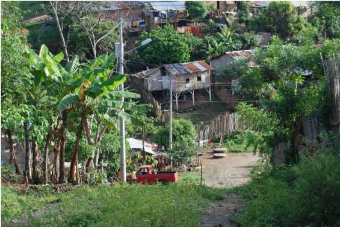
Figura 7. Barrios de Mocache en riesgo a deslizamientos
