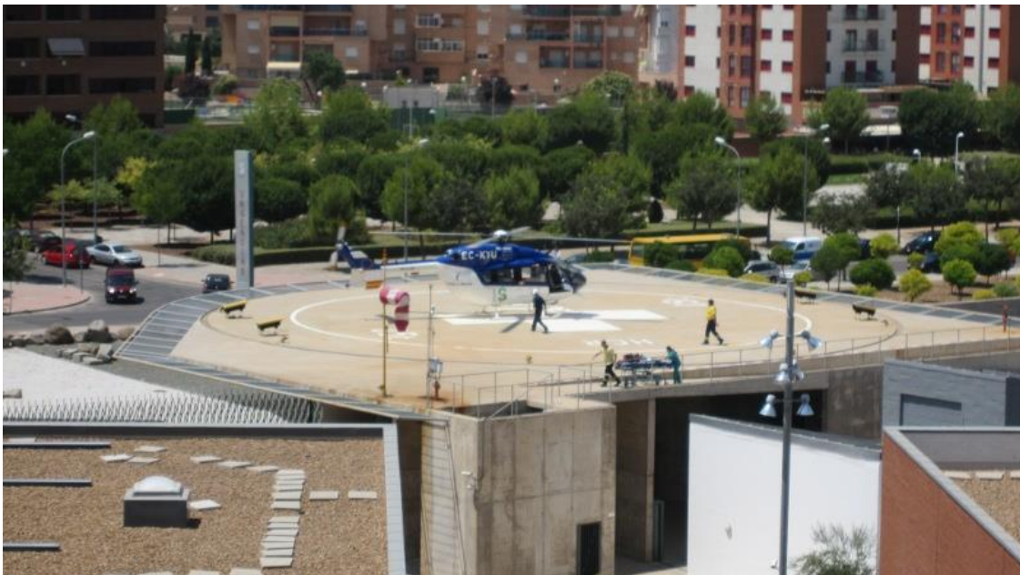
Figura 4-22 Helisuperficie del HGUCR, integrada en el propio edificio hospitalario.
