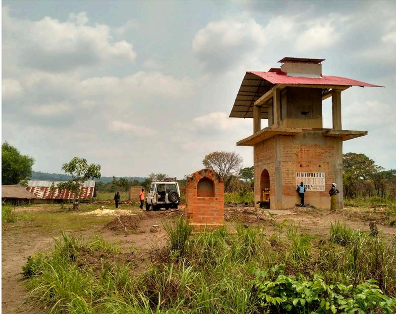
Figura 2. Vista panorámica de la ladrillera con el horno de cocción vertical a la derecha de la imagen.
