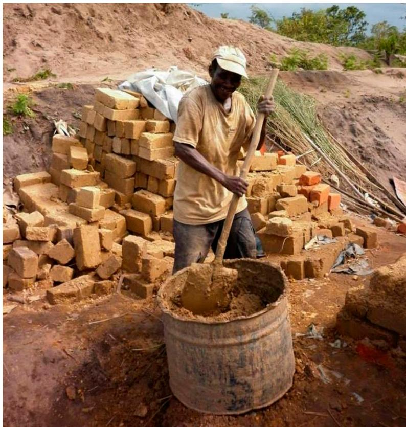
Figura 1. Trabajador preparando la mezcla para los ladrillos en la ladrillera. Fuente: María Ramírez.
