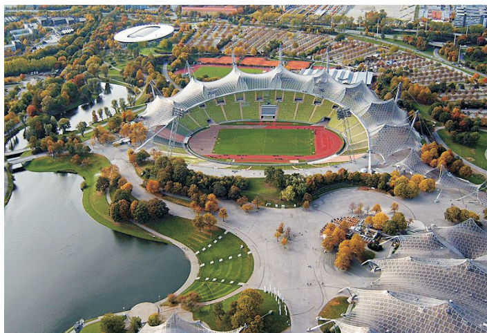
FIGURA 4. CUBIERTA ESTADIO OLÍMPICO MUNICH, GÜNTER BEHNISCH Y FREI OTTO, MÜNICH, 1972.
