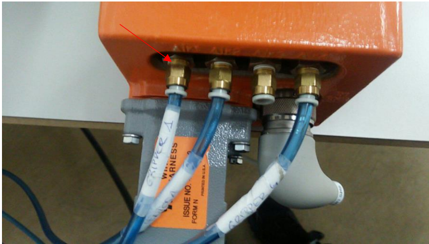
Figura 5.3 Conexión neumática de la parte trasera del IRB120
