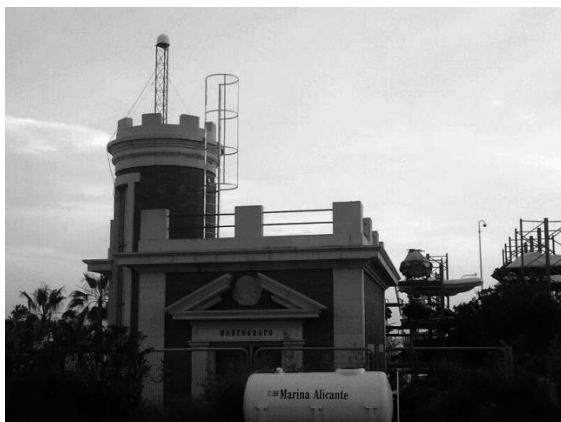
Fig. 4. Receptor GNSS de Alicante sobre el edificio del mareógrafo, perteneciente a la red de estaciones permanentes de la Red Geodésica Nacional de España.
