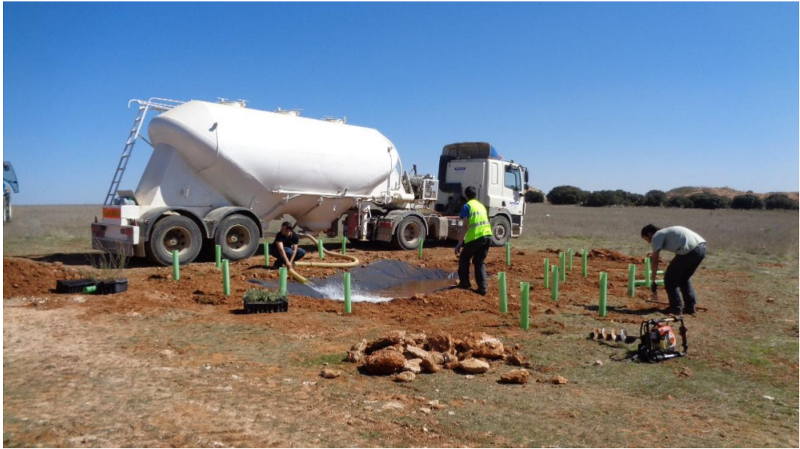
Figura A16. Llenado de la charca mediante cuba
