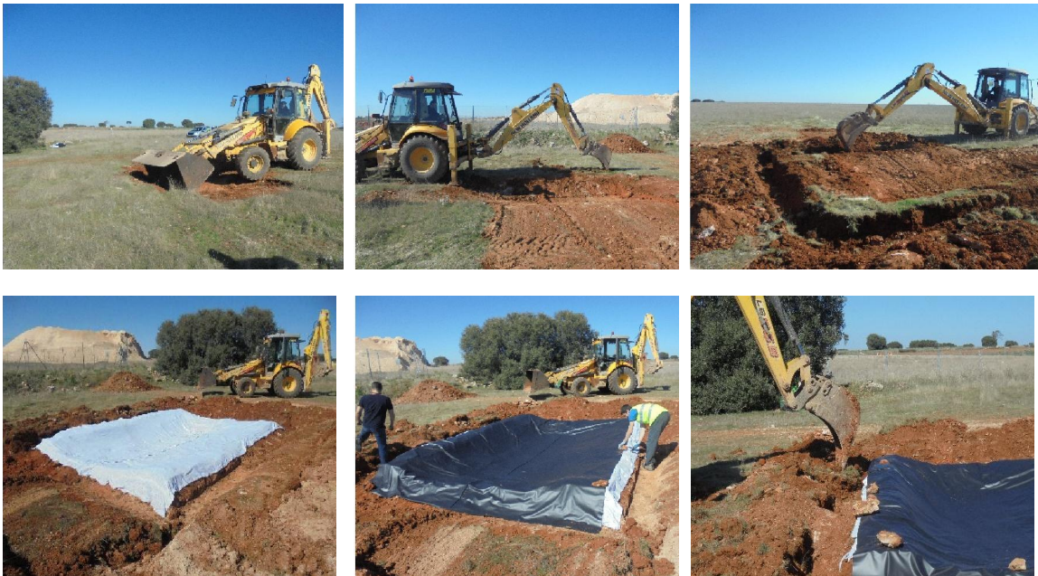
Figura A15. Cronosecuencia del proceso de creación de la charca para anfibios con retroexcavadora
