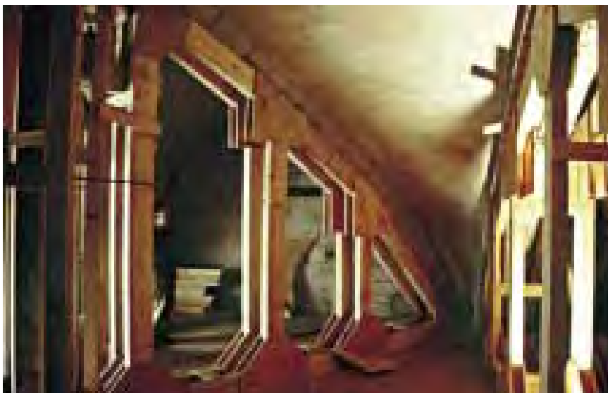
Imagen 599. Vista general del apeo y cimbreo de las bóvedas del crucero sur y detalle de esta actuación
