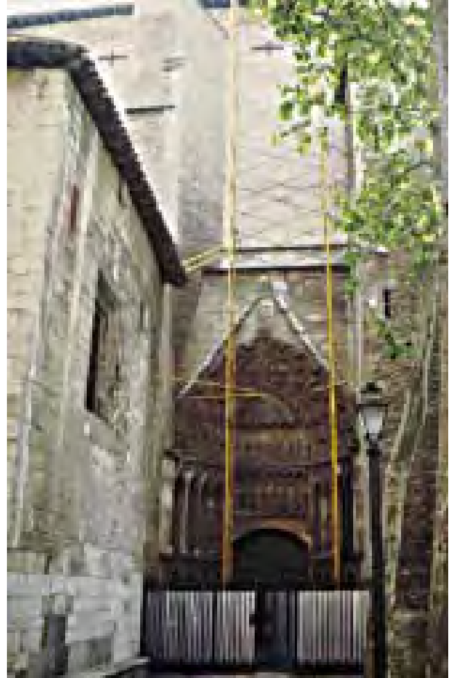
Imagen 458. Portada de Santa Ana y el machón de refuerzo de su contrafuerte septentrional semidesmontado por M. Lorente entre 1960 y 1965. Se observa la falsa trompa que imita a la construcción medieval de la torre noroeste del transepto (ver imagen 413), pero que aquí no se hace por verdaderos voladizos sucesivos, sino que es un mero acabado con morteros de un muro descarnado
