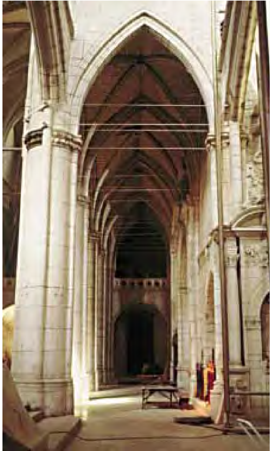
Imagen 452. Vista de la nave norte desde el transepto. Se puede ver la sucesión de los tirantes de los arcos perpiaños, cuatro por cada arco, dispuestos durante la restauración de 1960-65 para sustituir el efecto centrador de las cargas en los pilares de la nave que era producido por los arcos codales desmontados entonces
