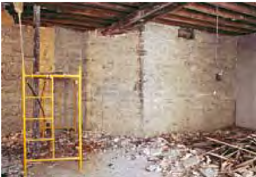
Imagen 93. Interior de la edificación 95 de la calle Cuchillería, en la entraplanta por debajo de la Sala Capitular. Descubrimiento del lienzo de la antigua estructura de la Catedral a la que se adosa esta edificación
