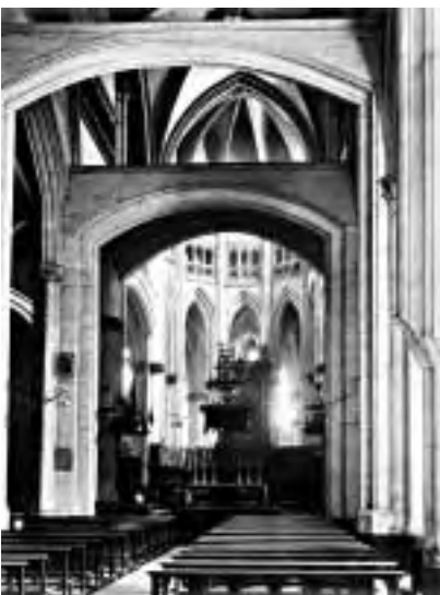
Imagen 57. Interior de la Catedral Vieja de Vitoria, con los arcos codales, antes de la restauración de M. Lorente. Archivo del Territorio Histórico de Álava. DAF (H) c. 4, nº61
