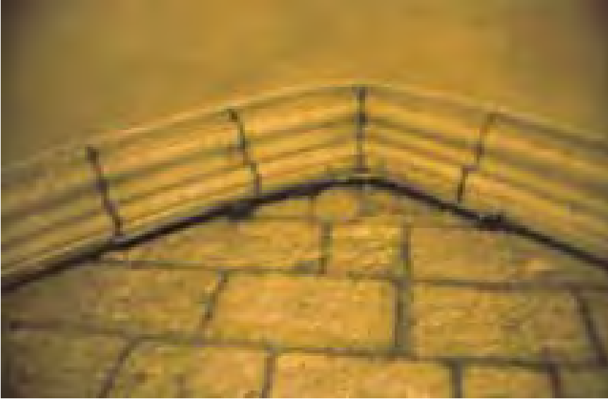
Imagen 487. Separación del plemento y su arco formero del alzado del muro de cierre
