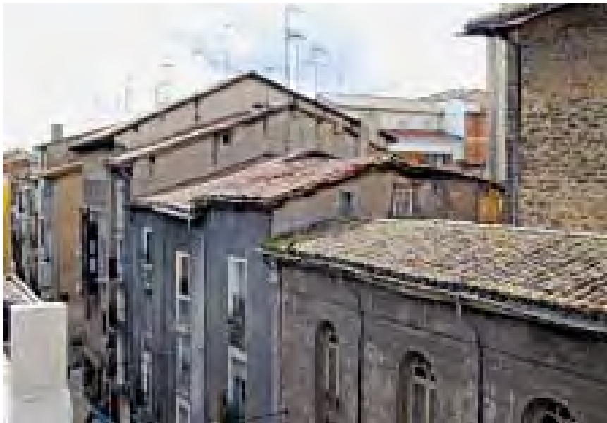
Imagen 94. Vista de las cubiertas de algunos edificios de la calle Cuchillería
