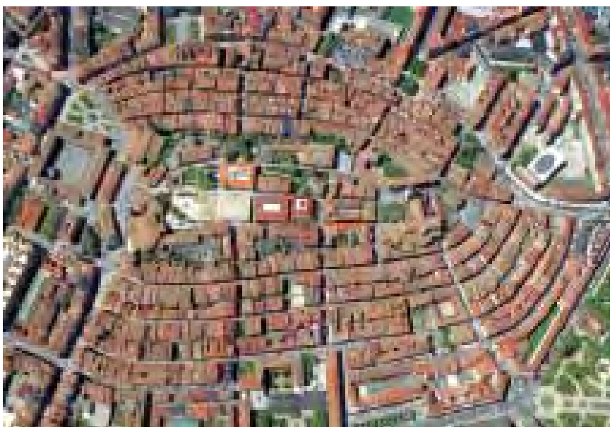
Imagen 85. Foto aérea con viviendas adosadas a la Catedral
