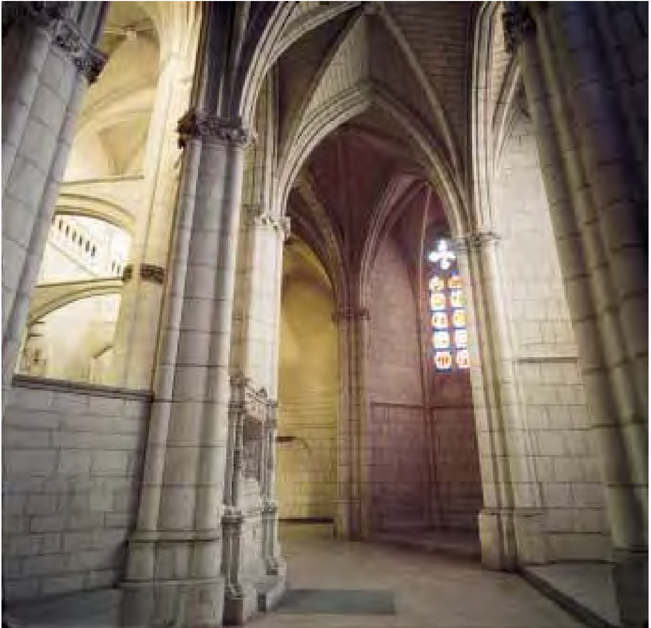
Imagen 22. Aspecto general de los absidiolos, construidos en la fase Gótico A. Estos absidiolos fueron levantados en dos fases de obra. En la primera de ellas se levanta la mitad meridional, avanzando hacia el norte en un segundo momento
