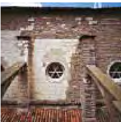
Imagen 54. Detalle de ventanal circular construido en la fachada sur de la nave durante la restauración de Lorente
