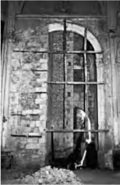
Imagen 450. Alzado lateral del muro medianero entre la capilla de los Reyes –en la foto– y el transepto meridional. Se aprecian los zunchos de hierro que ligan el refuerzo del muro –parte derecha del mismo– con el muro antiguo –parte izquierda– y cómo el refuerzo y el machón que se ve al fondo ocupan casi la mitad de la superficie útil de la capilla. Archivo Municipal de Vitoria. Autor: anónimo. Ref. P-307
