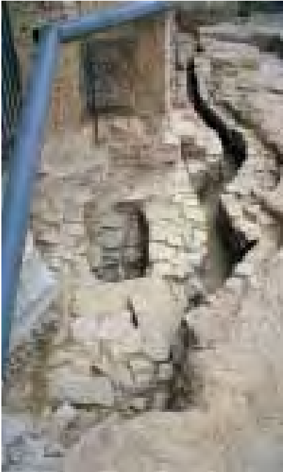
Imagen 49. Atarjea del siglo XIX utilizada para evacuar las aguas procedentes de las bajantes de la Catedral
