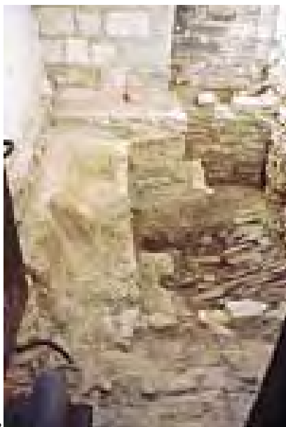
Imagen 483. Cimentación del contrafuerte de Santa Ana, en el centro, y del cierre del muro de la desaparecida capilla de los Reyes, al fondo
