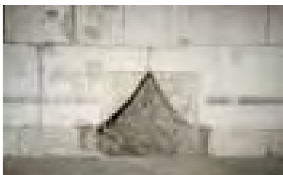
Imagen 17. Aspecto del forro de sillería que oculta por el interior de la iglesia los vanos de la obra iniciada por Alfonso VIII, una vez descubiertos tras la lectura estratigráfica
