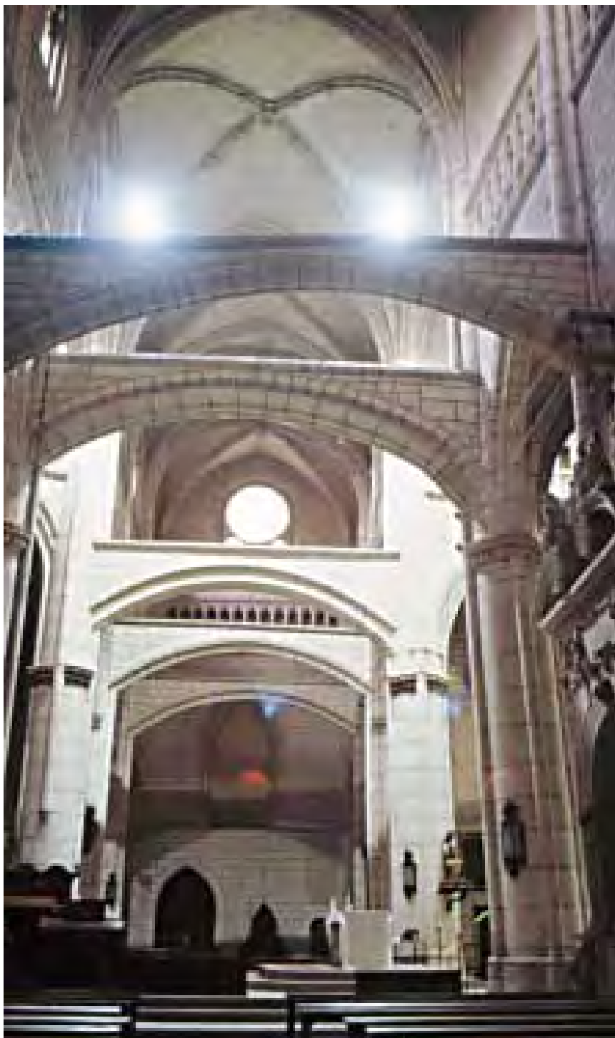
Imagen 440. Vista hacia el sur de la nave del transepto con los arcos codales que aún permanecen intactos. Se puede observar que todos ellos tienen distinta técnica de ejecución y diferente trazado
