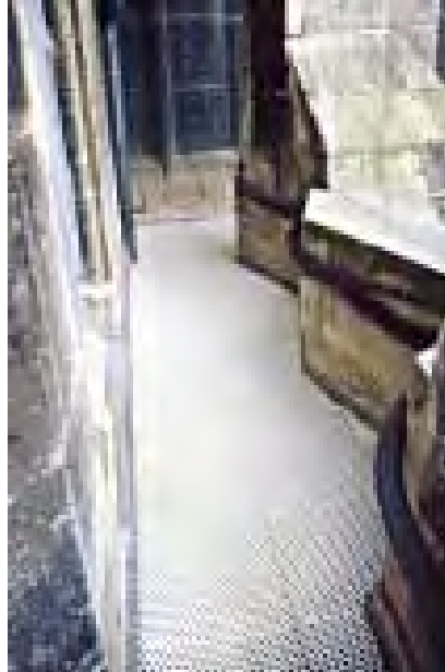
Imagen 595. Intervención en el pasillo de ronda
