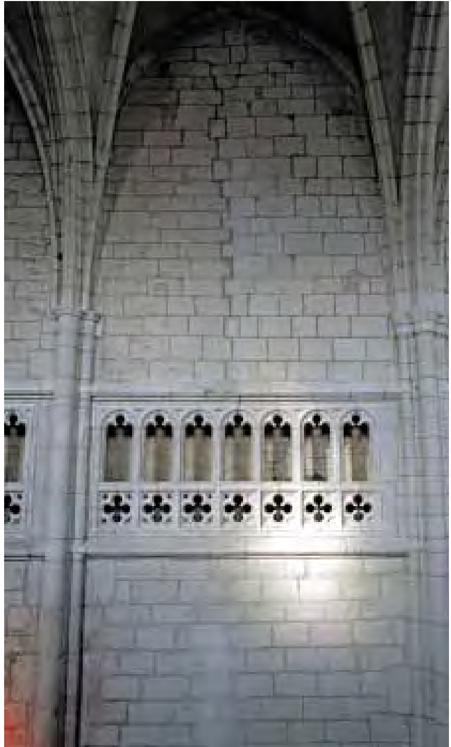
Imagen 423. Interior del ándito del triforio oeste del brazo sur del transepto. En primer plano, a izquierda y derecha, se aprecia el cambio de alineación de los muros debido al adelantamiento de los pilares del crucero
