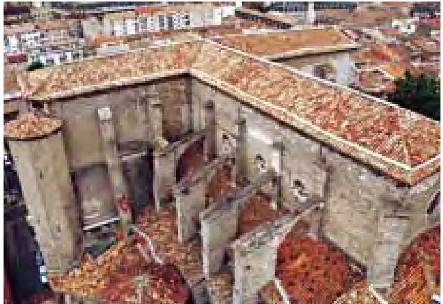
Imagen 441. Vista aérea del sistema de arbotantes septentrional de la nave central. Se aprecia la distinta traza y ejecución de cada uno de ellos y de los botareles en que descargan salvando la nave norte. Al fondo, en el segundo tramo de la nave del transepto, se observa el contrafuerte bajo y ataludado construido por M. Saracibar hacia 1870. También se puede apreciar el pequeño retranqueo del muro recreado sobre los cierres de las naves altas al construir las cubiertas superiores con estructura de madera
