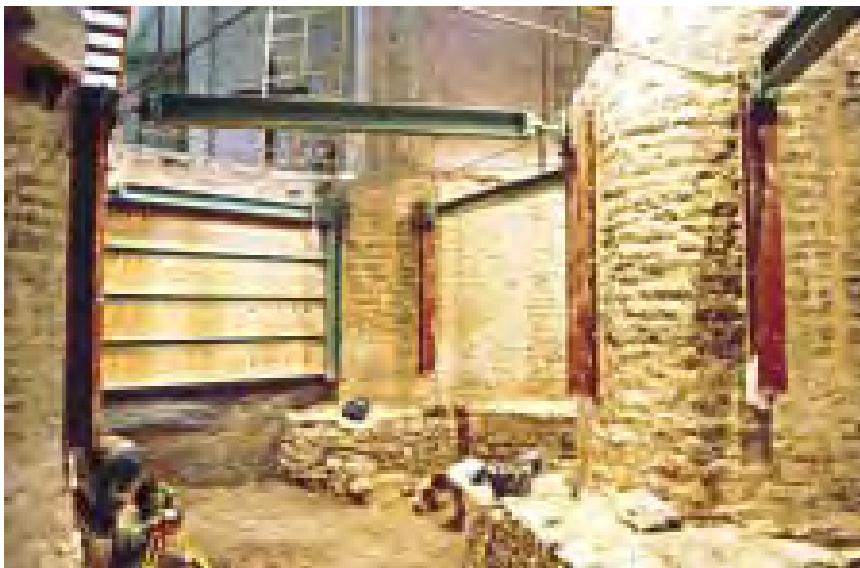
Imagen 605. Vista de la entibación realizada en los cortes de las excavaciones
