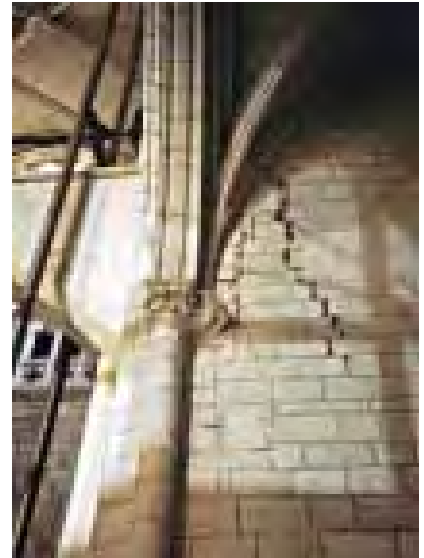
Imagen 501. Grieta en el muro medianero de las capillas del brazo norte del transepto, junto a la pilastra de la nave, producida por la apertura del arco fornero
