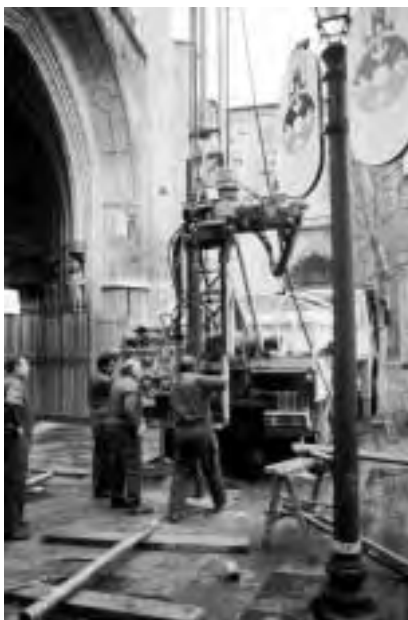
Imagen 333. Equipo utilizado en la perforación de sondeos
