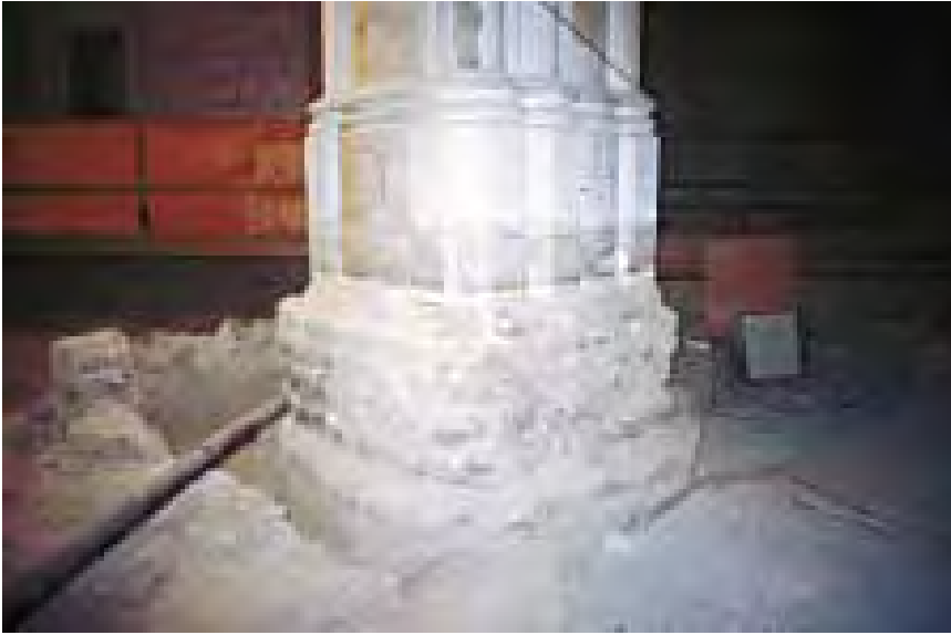
Imagen 521. Cimiento del primer pilar norte de la nave central, bajo el coro, bien aparejado con lajas de caliza y juntas de mortero, y bien apoyado en la roca sana, cortando para ello los restos de construcciones anteriores
