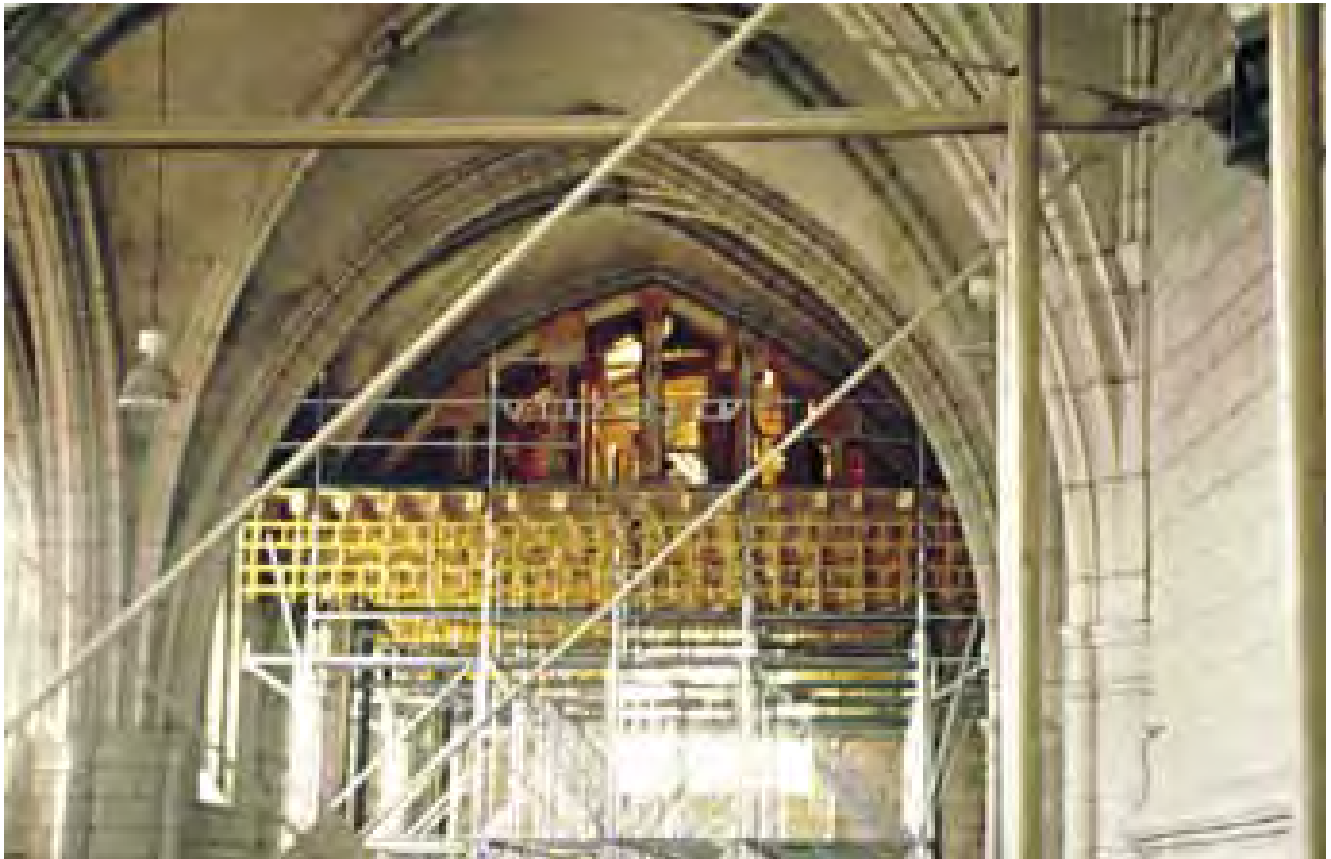
Imagen 599. Vista general del apeo y cimbreo de las bóvedas del crucero sur y detalle de esta actuación
