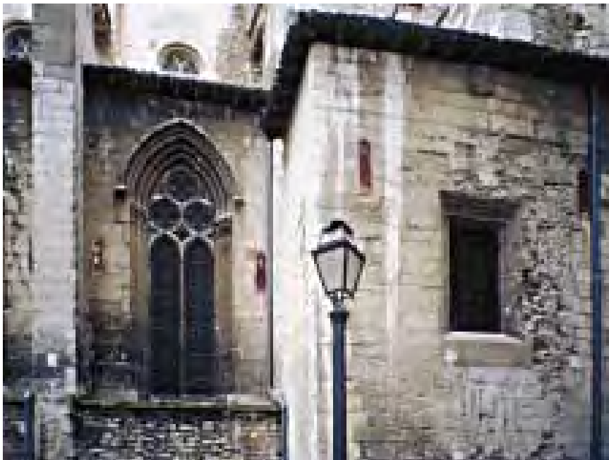
Imagen 453. Exterior de la capilla de San Bartolomé y de la nave sur. Se pueden ver las placas de anclaje de los tirantes dispuestos en los arcos perpiaños del interior de esta nave
