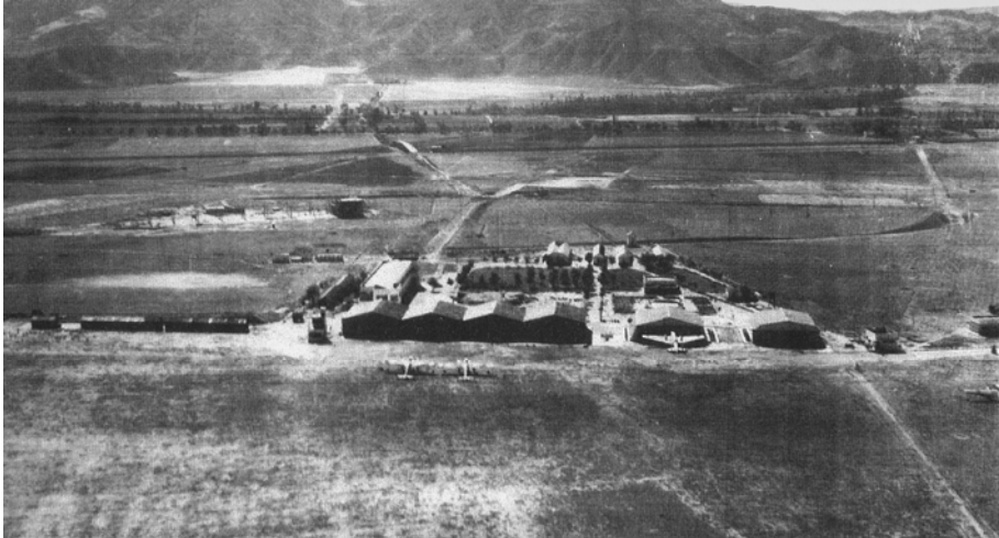
Fig. 183: Foto del aeródromo de Alcalá en 1.942, con los hangares en construcción al fondo a la izquierda 654 .
