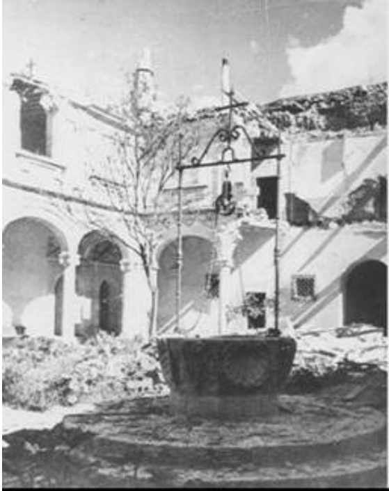
Fig. 143: Estado del patio trilingüe después de la Guerra Civil 558 .
