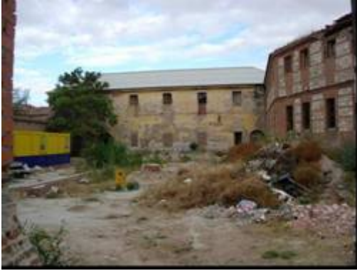
Fig. 218: Fotografía del estado actual de la zona trasera del Colegio.
