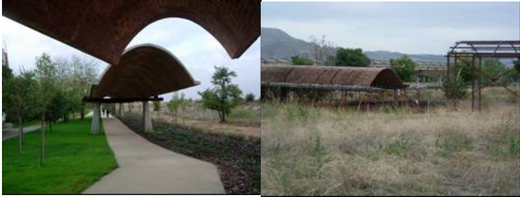
Fig. 186: Vistas de las pérgolas originales y de la copia en tubo de acero.
