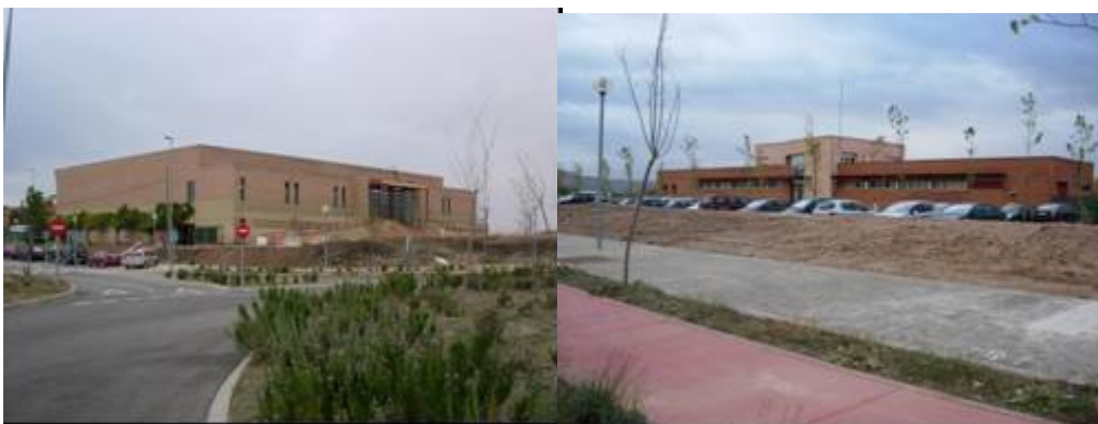
Fig. 193 Vistas del polideportivo y de los vestuarios exteriores.
