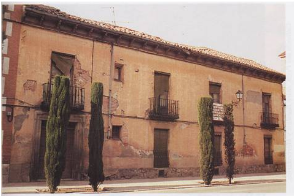
Fig. 206: Fachada del Colegio antes de su Rehabilitación. 677
