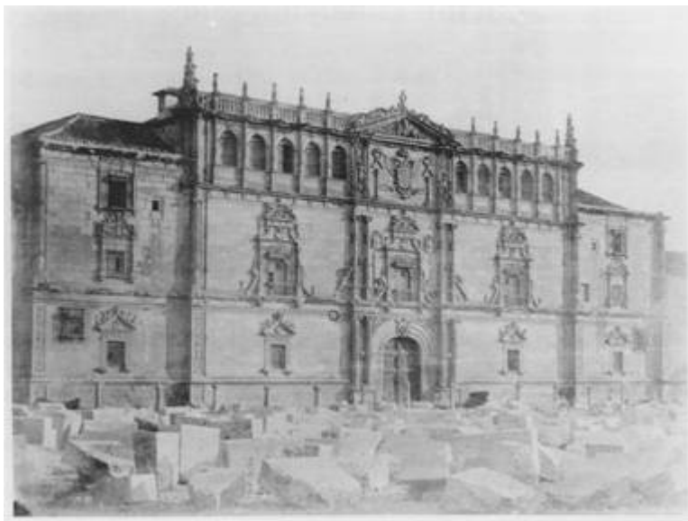
Fig. 174: Plaza de San diego durante la demolición del Convento de San Diego en 1859 640 para la construcción del nuevo cuartel.
