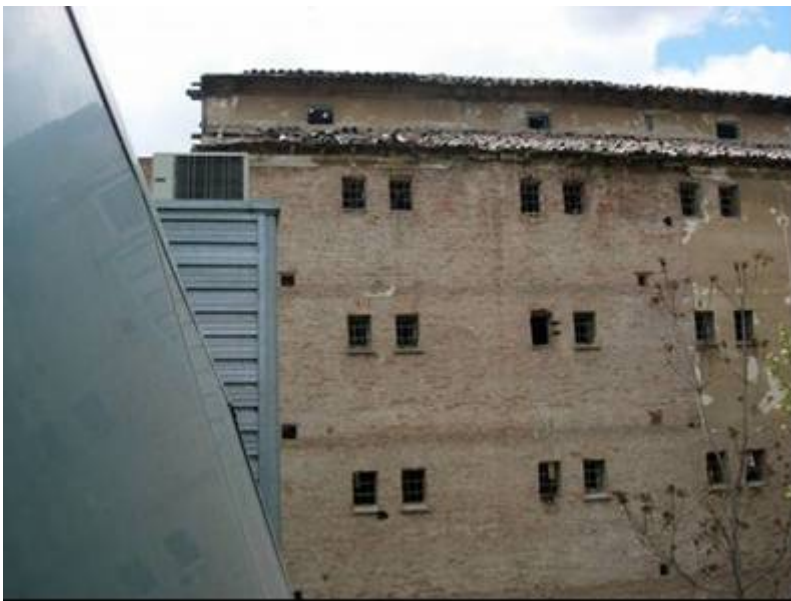
Fig. 221: Vista del encuentro entre la facultad de Documentación y Bibliotecomía (Maria de Guzmán, y la antigua cárcel de mujeres.
