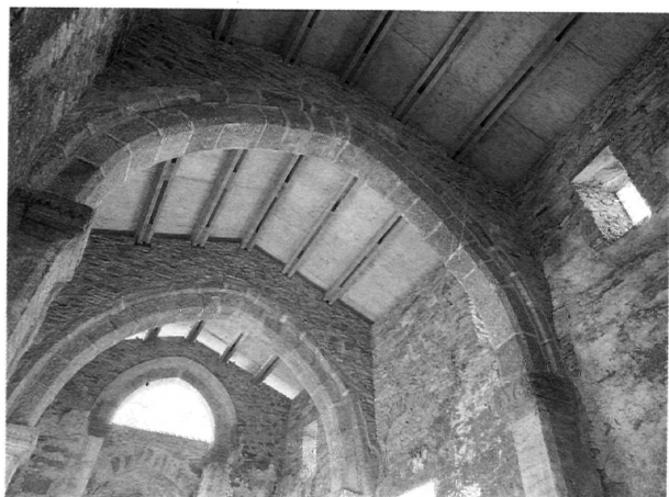
La cubierta del aula.
