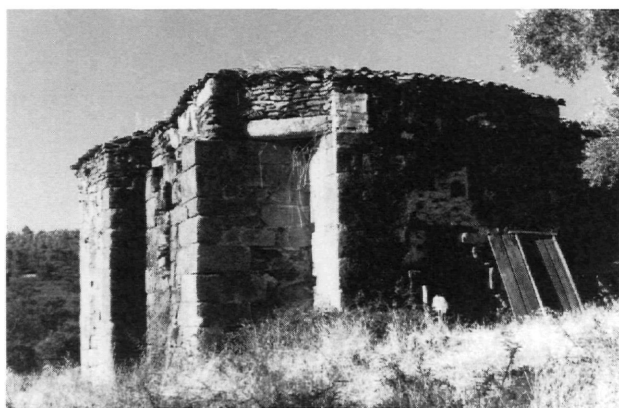
Cabecera de la iglesia antes de la restauración.
