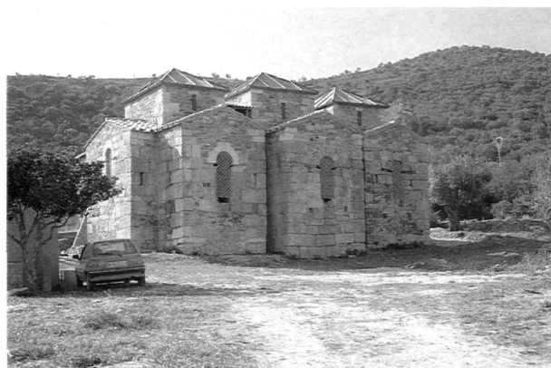
La cabecera después de la restauración.
