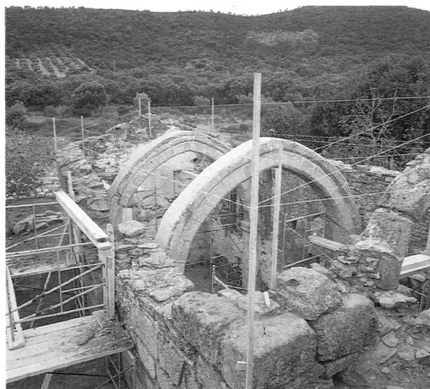
Replanteo de la cubierta del aula.
