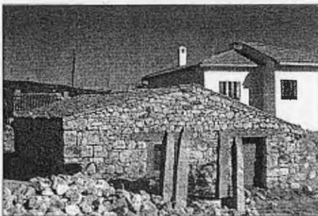
Establo en la calle de las Eras con potro en primer término
