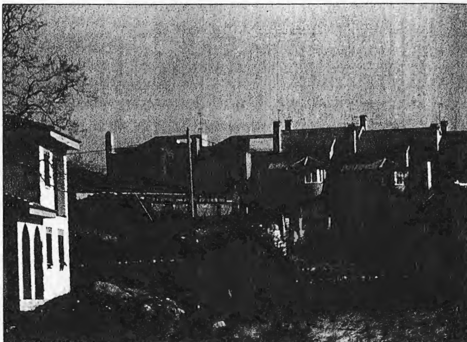
Viviendas en hilera. Vista general. A la izquierda dos con la cubierta plana original
