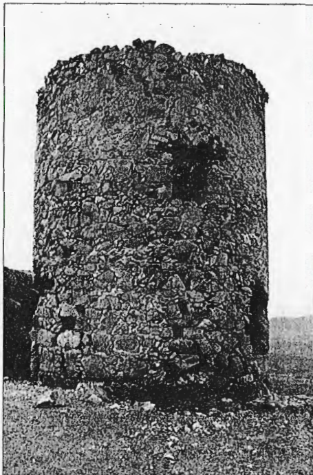
Torre de la Mina
