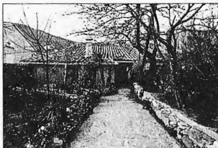
Vivienda en la calle Real , 65
