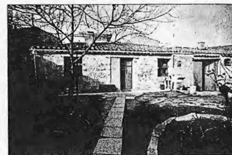
Vivienda en la calle Fuente de Maruste, 13, 15 y 17
