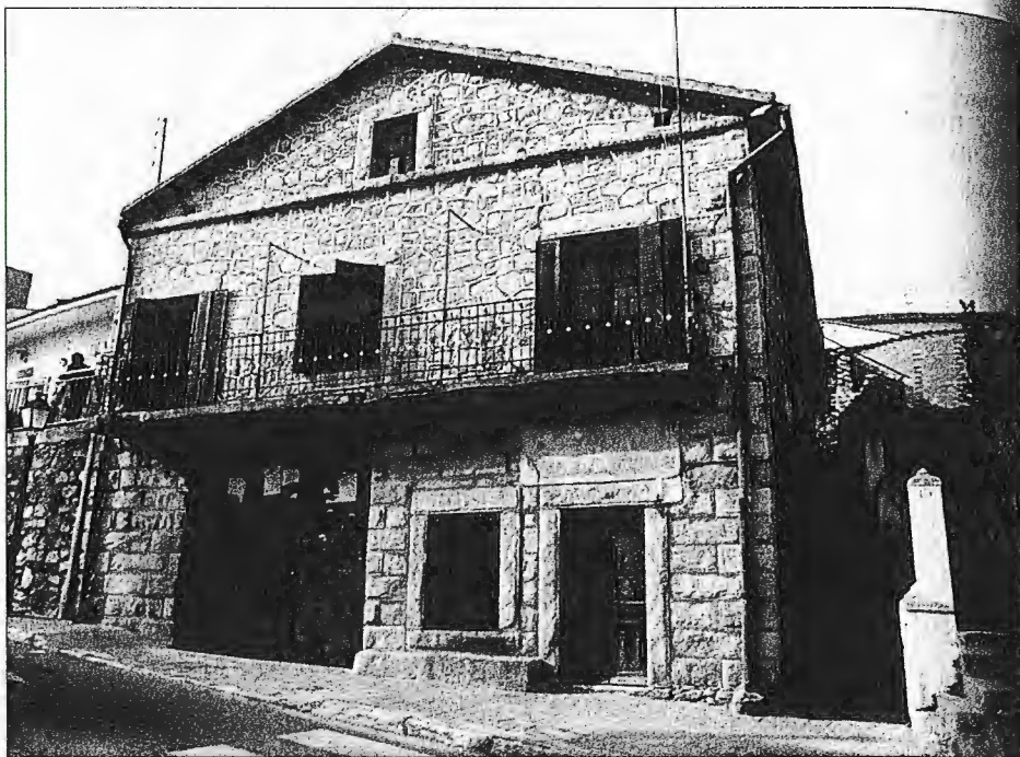
Vivienda en la calle Mayor, 45
