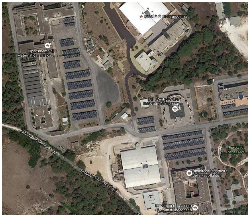
Figura 26. Vista aérea del parque fotovoltaico (Fuente: Google Maps)
