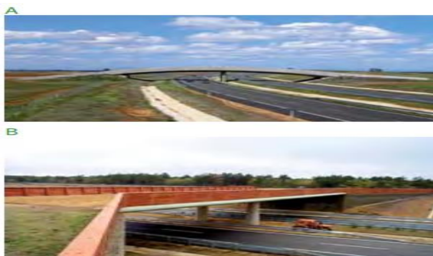
Fig. 26. Distintas medidas para mejorar la conectividad. Imagen superior. Tipos de elementos estructurales transversales de una autovía (REAOC, apuntes de clase, 2016). Imagen intermedia. Diámetros de distintas estructuras (REAOC, apuntes de clase, 2016). Imagen inferior. Diseños de pasos superiores específicos: tipo puente de tableros(A) y abovedado (B). Fuente: Juan E. Malo y Cristina Mata (2011), en Balaguer et al. (2011).
