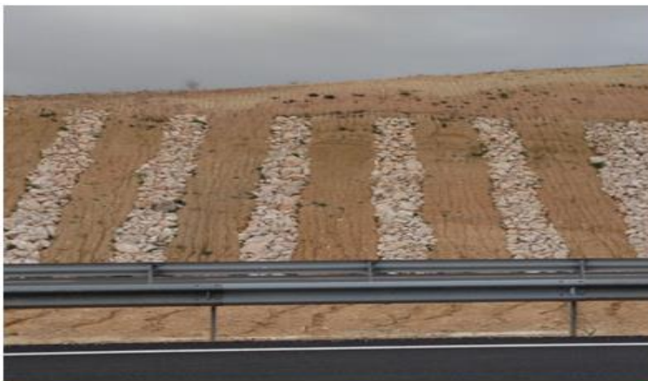
Fig. 17. Estructuras tipo “mecha”, para favorecer la estabilidad geomorfológica de taludes de carretera. Ejemplo de un talud en la Autovía 2 de España, Madrid Valencia, a la altura de Cuenca.
