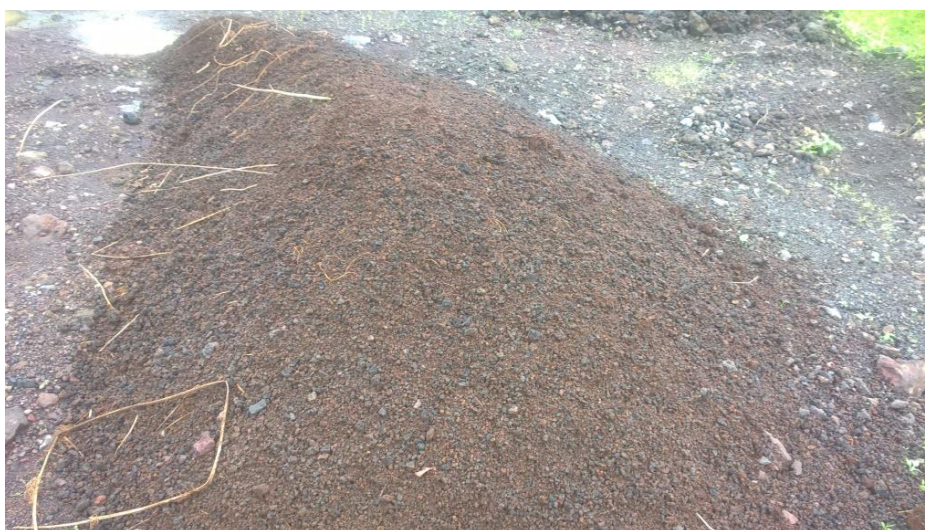
Fig. 24. Depósito de materia orgánica para el tratamiento de algunos terraplenes en la Autovía Nacional Malabo-Luba (Foto: S. Nsue Esono).
