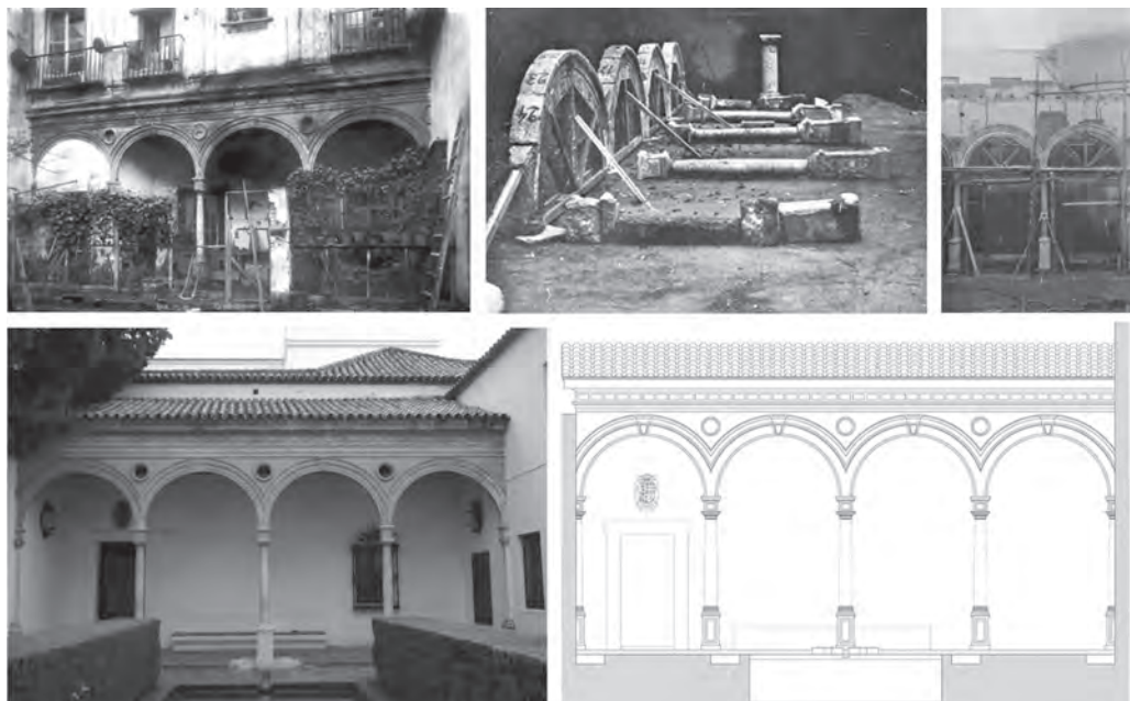
Figura 03. Logia de la Casa de los Levías. Antes de su desmontado, en fase de montaje y estado final.
