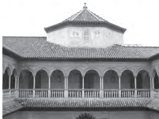
Figura 10. Fachada de poniente del Patio de las Doncellas antes y después de la intervención.
