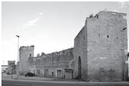
Figura 01. Vista de parte de los restos de muralla y torreones conservados.
