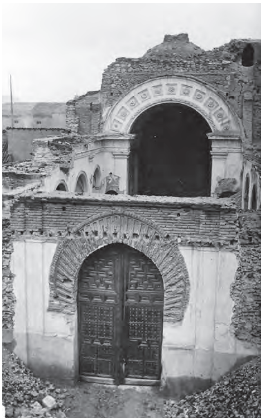
Figura 06. Iglesia de San Gil. Proceso de demolición. Foto Goñi (AGA).
