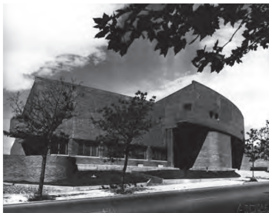
Figura 05. Archivos Imágenes Digitales, FADU UBA. Baliero / Córdoba. Foto Fachada Exterior de la obra construida CMNSL en Madrid, 1970.
