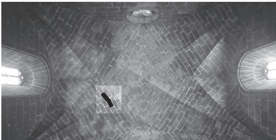
Figura 10. Vista de un tramo de la bóveda de la capilla Real con un sillar destacado, análogo al que se ha analizado en el presente artículo.
