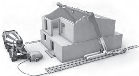
Figura 07. La impresión del proyecto Printed Constructions .
