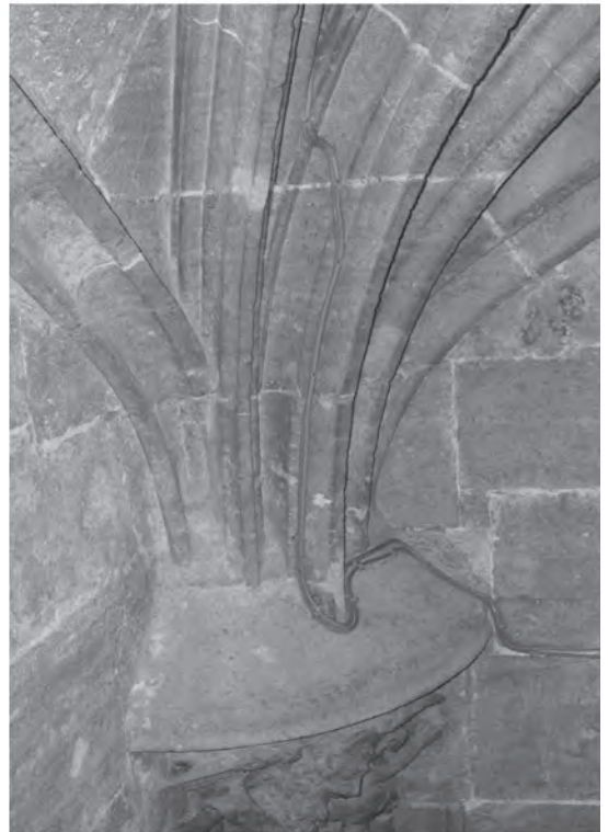
Figura 05. Arriba, imagen de la bóveda de la Capilla de la Lonja. Abajo, uno de los arranques donde puede verse el perfil de los formeros junto a diagonales y terceletes. (Foto: E. Capilla. 31-10-2004)
