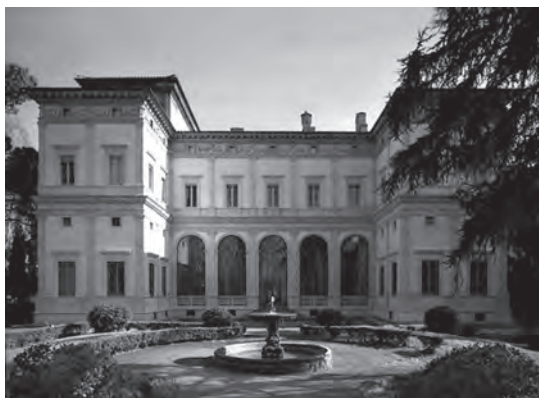
Figura 01. Villa Farnesina, prospetto Nord.
