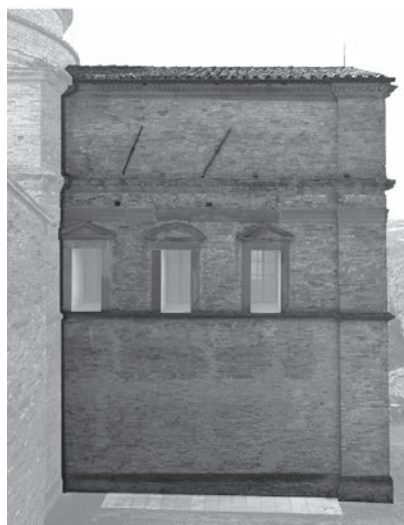
Figura 03. Fotopiano ad alta risoluzione del prospetto Est
