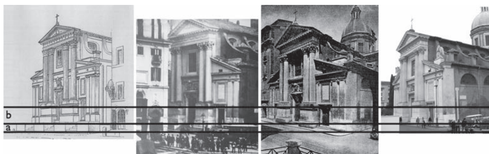
Figura 08. Confronto del disegno di progetto con le diverse fotografie storiche. Da sinistra verso destra: 1834: Disegno del Valadier. 1895: fotografia con la quota stradale antica e la parte inferiore del basamento (a) intatta. 1930: fotografia con la quota stradale rialzata e la parte inferiore del basamento scomparsa. 2015: fotografia attuale.
