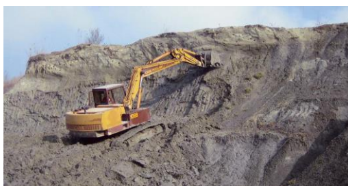
Figura 4.7 Máquina excavadora preparando la cara vertical de un acopio (Fuente: Bachmann et al., 2008)
