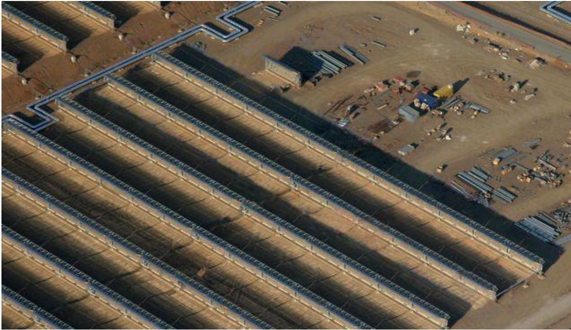
FIGURA 1 <LAZO SOLAR DE UNA CENTRAL CCP >
