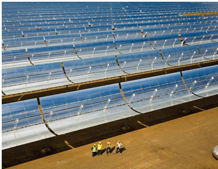
FIGURA 7 < CILINDROS CONECTADOS EN SERIE EN UNA PLANTA TERMOSOLAR >
