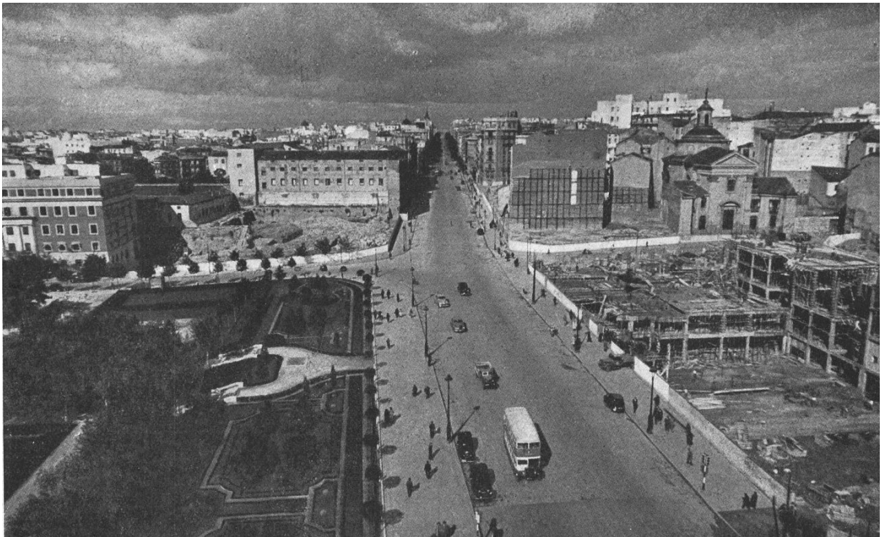
Plaza de España con el edificio España en construcción. Gran Madrid 3, 1948
