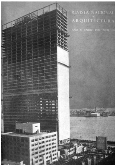
Edificio de Naciones Unidas en construcción. Nueva York. Portada de RNA 109. 1951.
