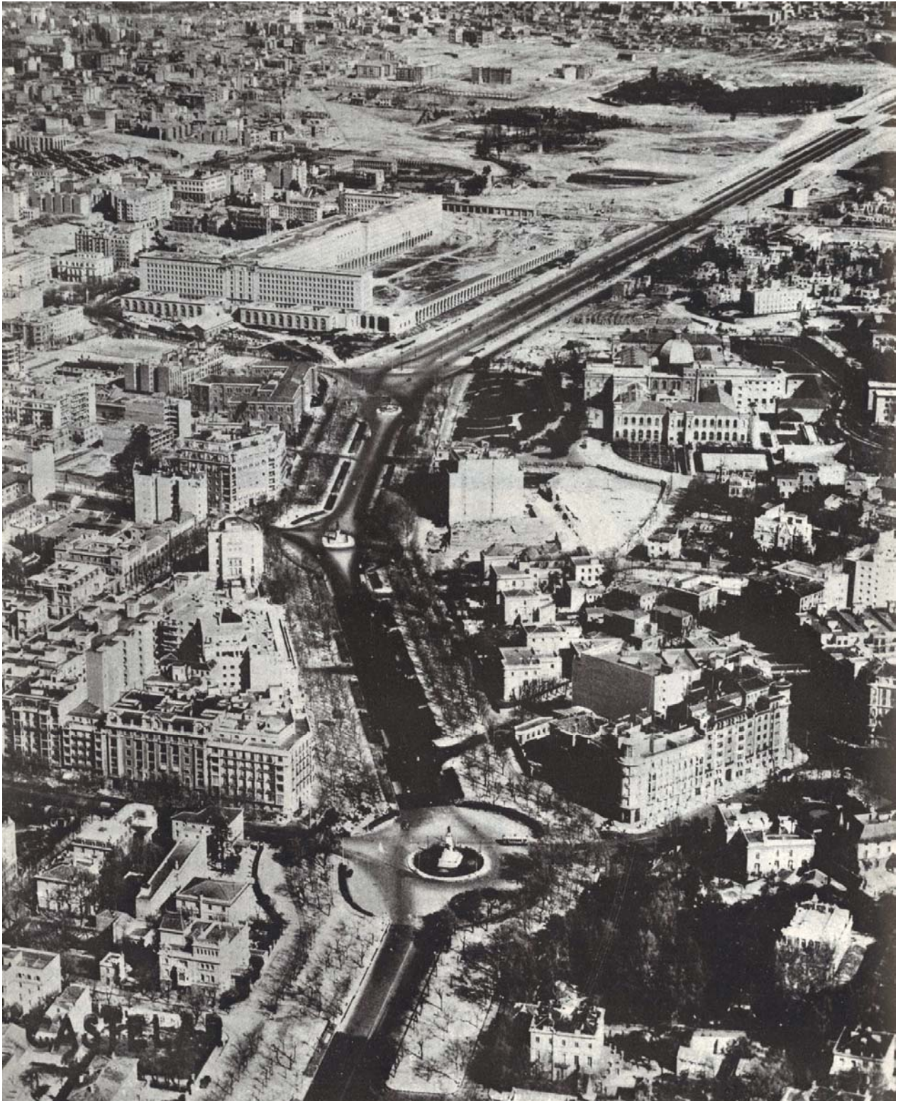
Imagen de la prolongación del Paseo de la Castellana, con los Nuevos Ministerio en construcción. . Gran Madrid 15, 1951.
