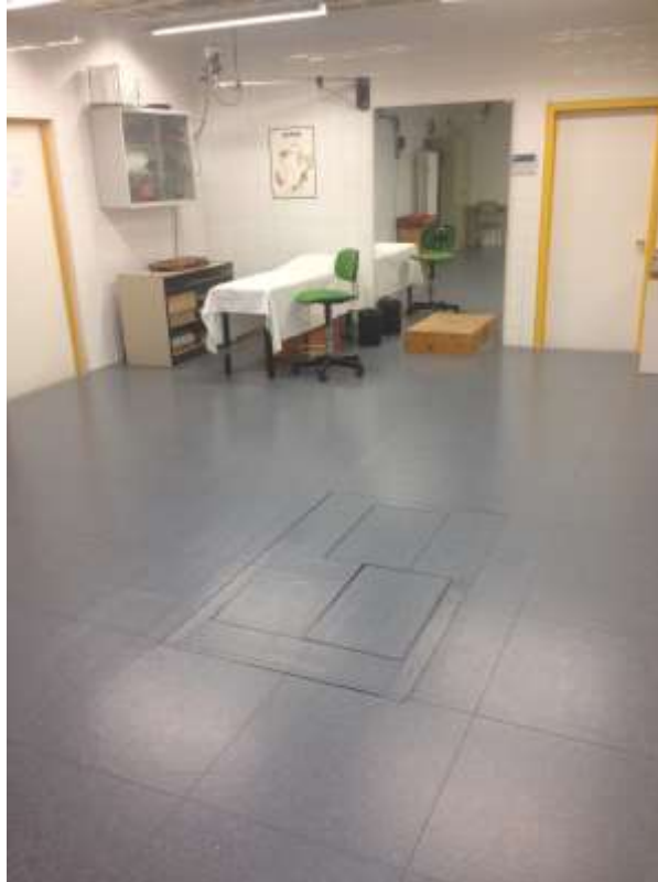
Figura 4.4 Pasillo de marcha
