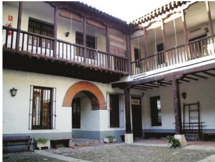
Figura 1: Patio central con galería de dos alturas.
