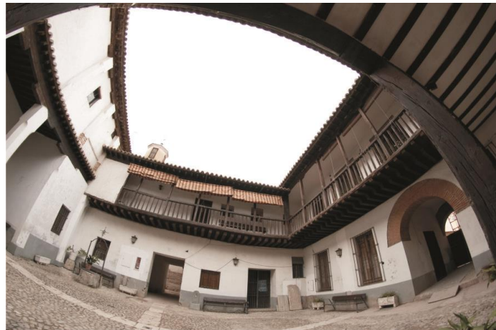
Figura 2: Galería original tabicada del lado sur (izda.) y corredores de madera.
